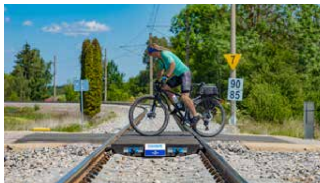
Opraveno je celkem sedm železničních přejezdů
