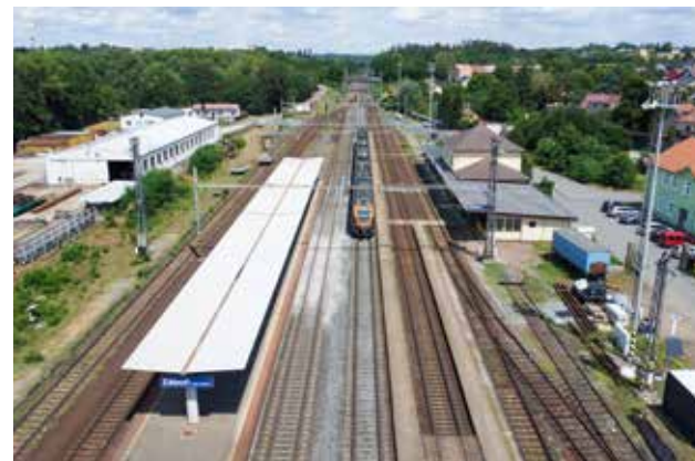
Opravy výhybek v Zábоří nad Labem
