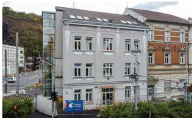
Přístup do pater zajistí nový prosklený vnější výtah
