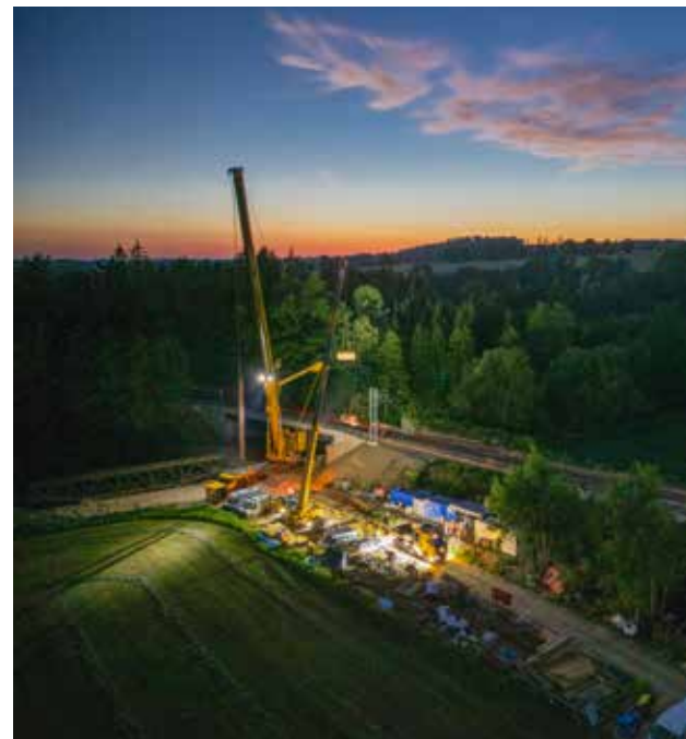
Osazování mostních konstrukcí v nočních výlukách
