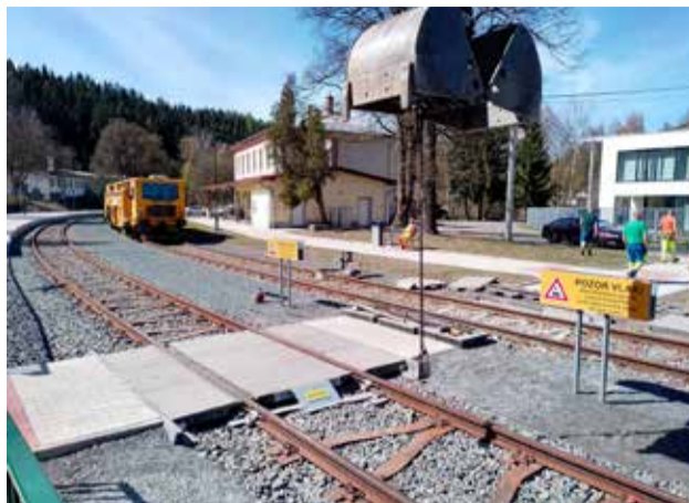
Na trati z Tanvaldu do Kořenova se čtyřmi tunely je 5000 ocelových pražců a více než 3300 ozubnicových hřebců
