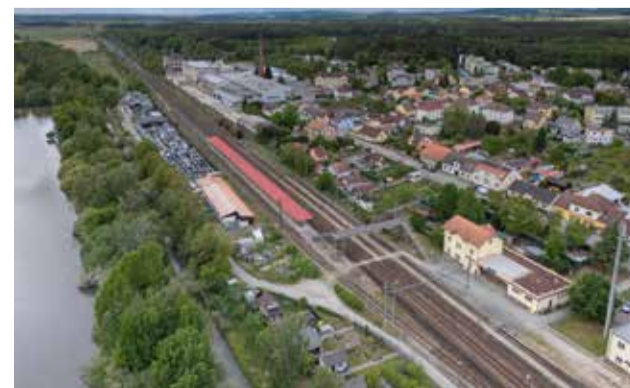
Ve stanici Zliv byly opraveny tři staniční koleje
