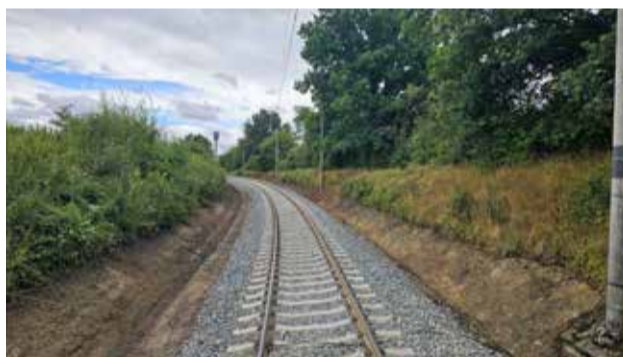
Oprava se týkala především železničního svršku
