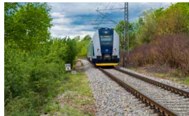
Na opraveném úseku je zřízena bezstyková koleje
