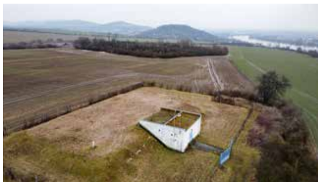
Původní vodojem před zahájením demolice
