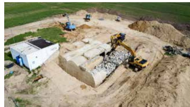
V polovině května byly demolovány komory
