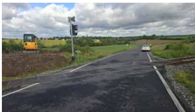
Na trase je opraveno devět železničních přejezdů
