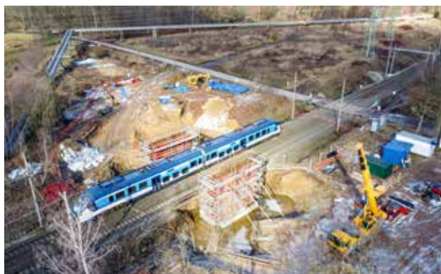
Nové přemostění trati mezi Málkovem a Prunéřovem
