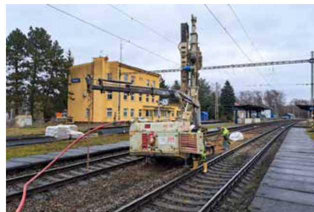
Přípravné práce ve stanici Pohled
