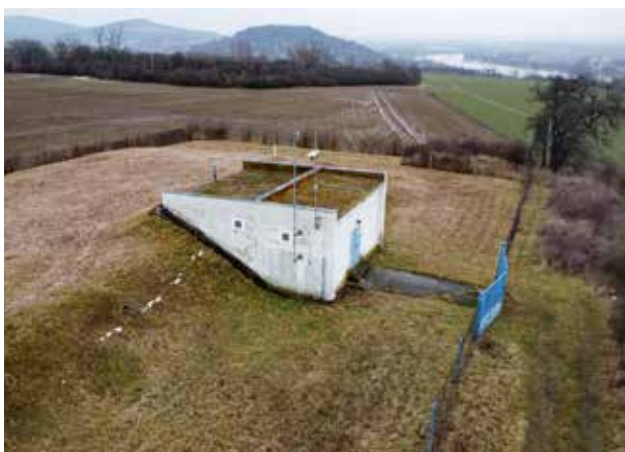
Původní vodojem bude kompletně rekonstruován
