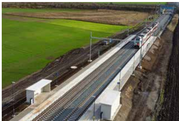
Sanace trati zvýší kapacitu na vytíženém koridoru
