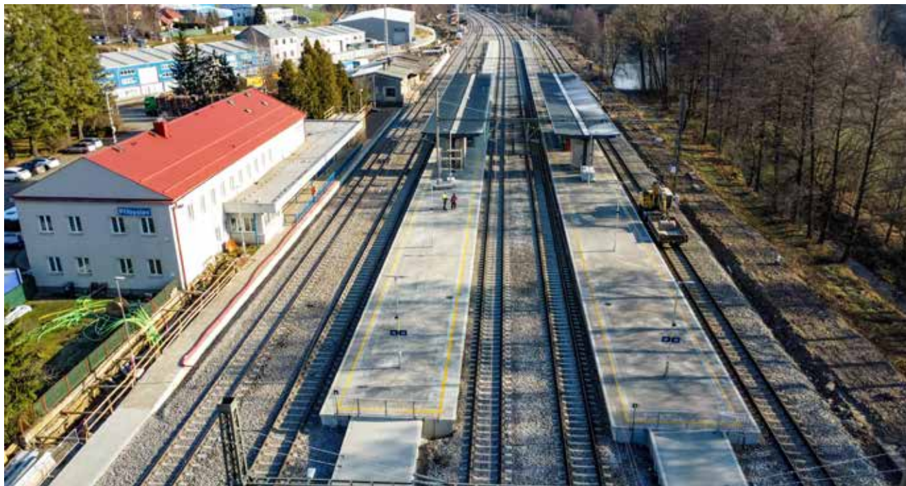
Obě ostrovní nástupiště jsou propojená podchodem, ze kterého je možné použít schodiště a nově také výtahy
