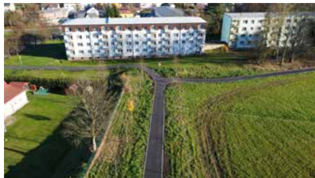
Intravilánová část cyklostezky má asfaltový povrch
