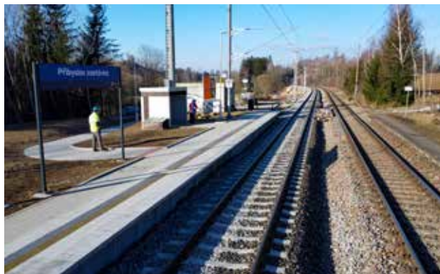
V zastávce Příbyslav bude nový podchod pod trať
