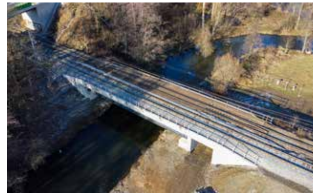
Ocelové mosty nahrazují komfortnější železobetonové
