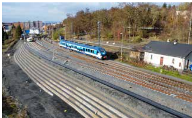
Kompletní sanace náspu trvala více než dva roky
