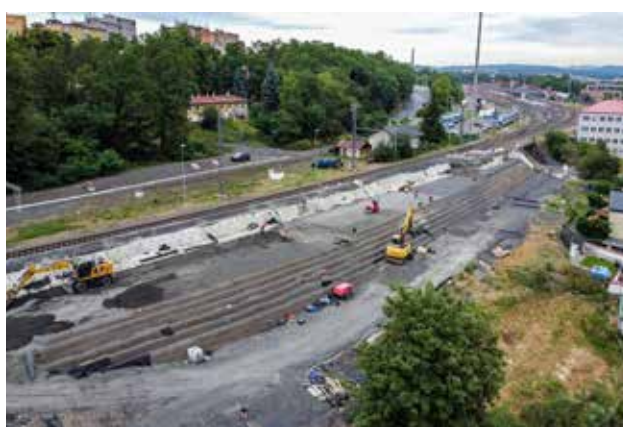
Stopadesátimetrový násep pod lichou kolejí
