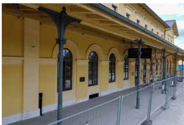
Zakryté nástupiště nadále podpírá 11 litinových sloupů
