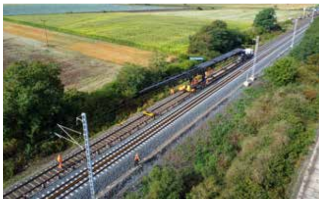
Snášení svršku pod první traťovou kolejí
