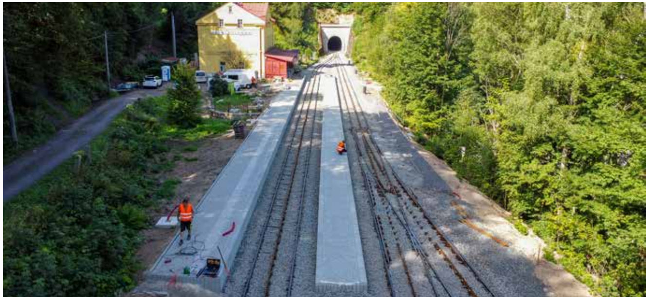
Naprostou raritou jsou nové výhybky v dopravě Dolní Polubný, které jsou rovněž osazeny ozubnicí
