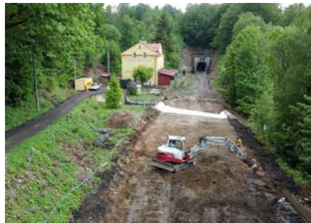
Dopravna Dolní Polubný projde zásadní rekonstrukcí
