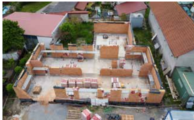
Budovaný objekt úřadu má zastavěnou plochu 350 m²
