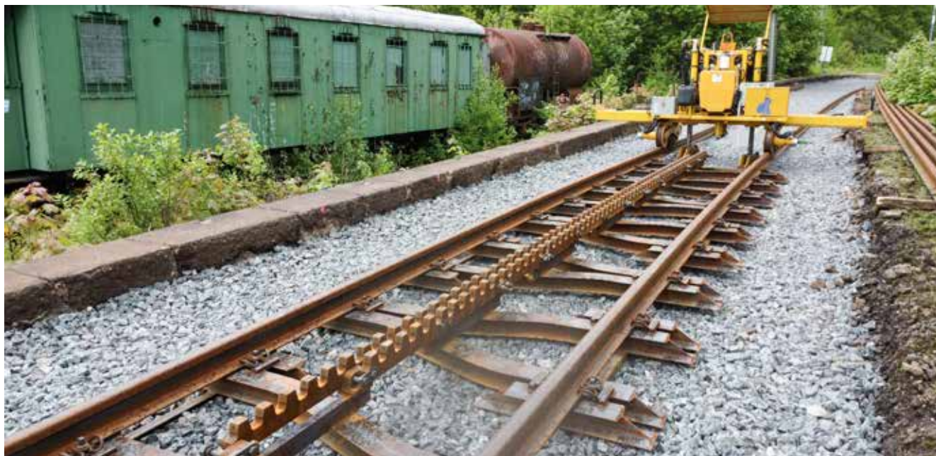
Za stanicí Tanvald je již k vidění nový kolejový svršek s ozubnicovou tyčí připevněnou na ocelové pražce
