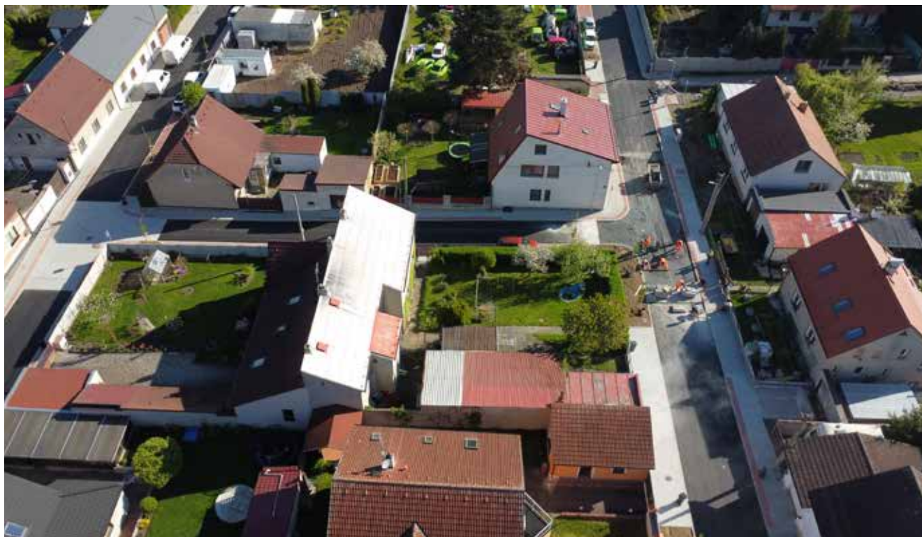
Rekonstrukce komunikací v Tuchlovicích se týkala dvou hlavních ulic a krátké propojky mezi nimi
