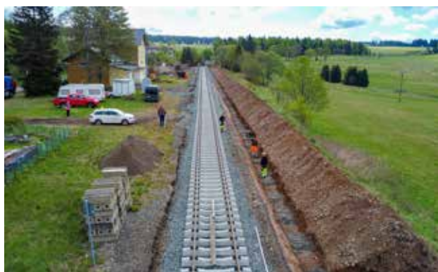
Redukce kolejí v Horní Blatné umožní nové odvodnění
