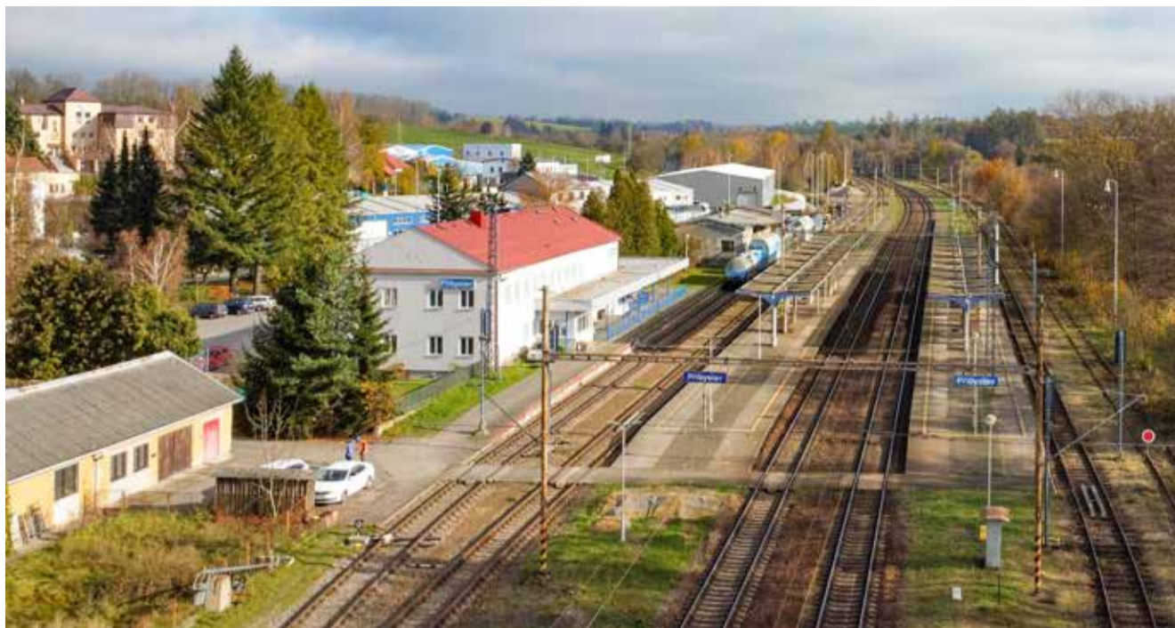
V Přibyslaví je nyní přístup na nástupiště zajištěn pouze po pevném schodišti, nově ho doplní trojice výtahů
