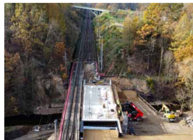
Přípravné práce zahrnovaly rekonstrukci čtyř mostů
