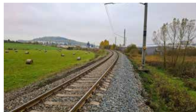
Celkem byly vyměněny více než tři kilometry kolejnic
