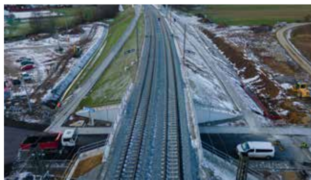
Nový most určoval postup stavby
