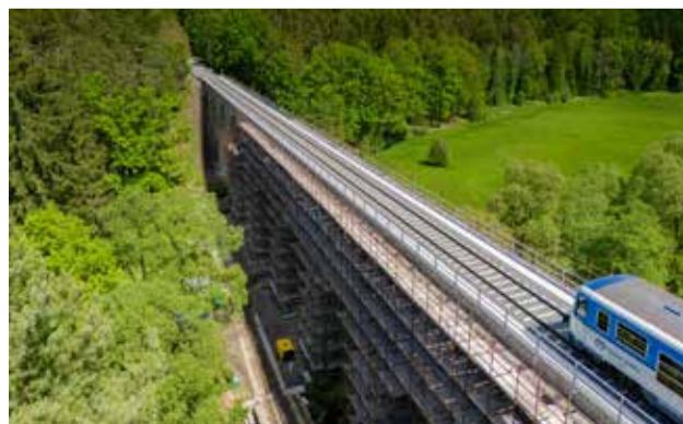
Oprava spodní stavby nebrání provozu na trati
