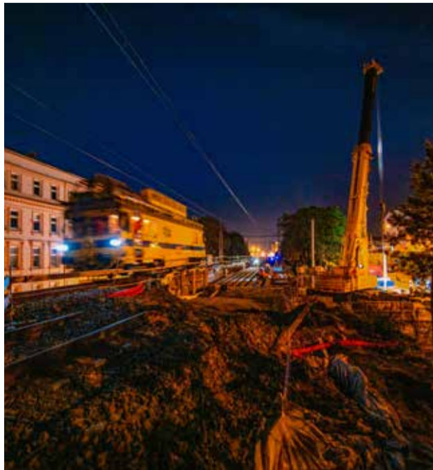
Rekonstrukci mostu provádíme po polovinách se zachováním jednokolejného provozu
