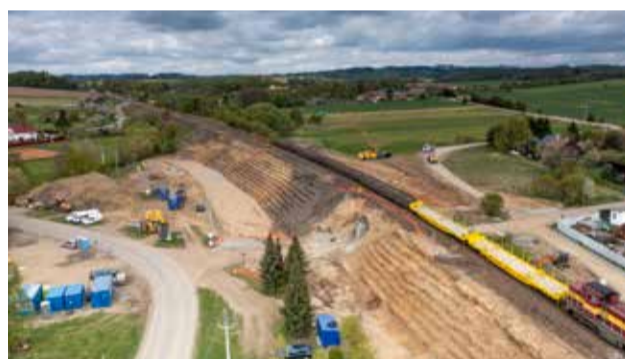
Zemní práce na železničním spodku ve Vlkově
