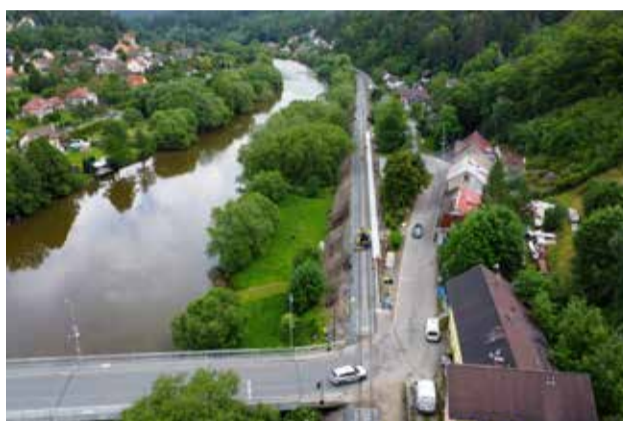
Oprava koleje a výstavba nástupišť v Choceradech
