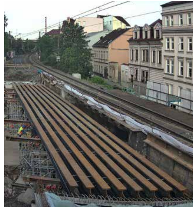
Rekonstrukci mostu provádíme po polovinách se zachováním jednokolejného provozu
