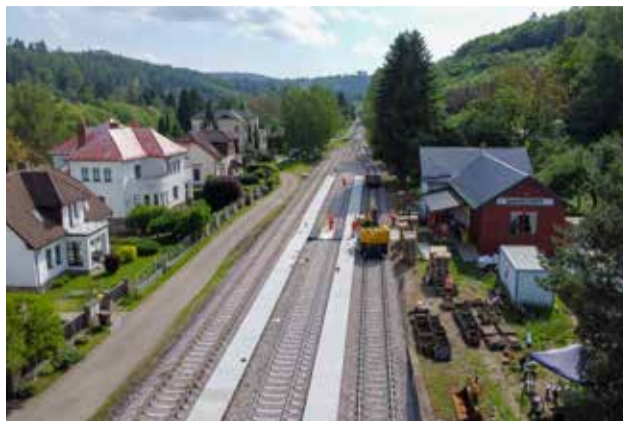
Oprava tří kolejí a nová nástupiště ve stanici Samechov
