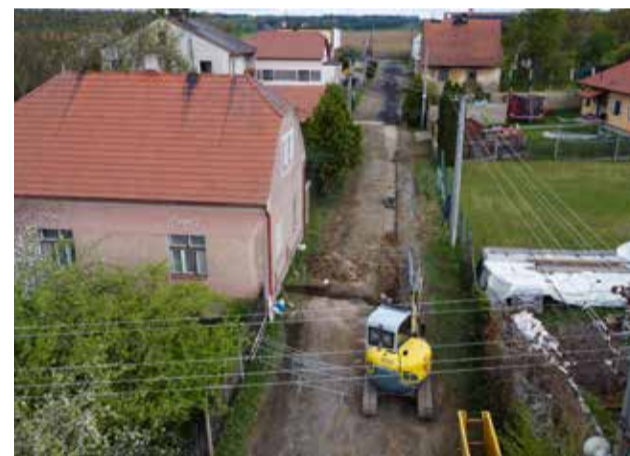
V obci Běleč realizujeme 2 km nového vodovodu
