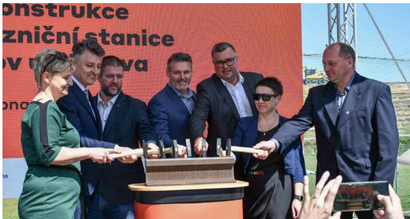
Symbolickým poklepáním na kolejnici oficiálně začala modernizace tří úseků havlíčkobrodské trati
