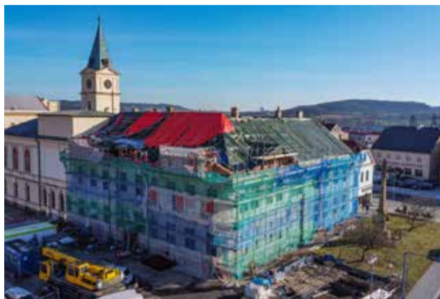
Objekt byl před rekonstrukcí ve špatném stavu
