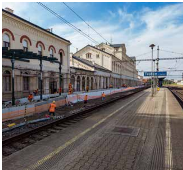
Rekonstrukce se dotkla také 1. nástupiště
