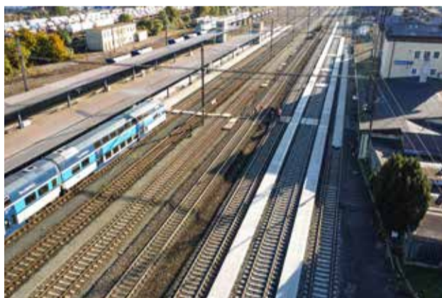
Oprava se týkala prostoru prvního nástupiště
