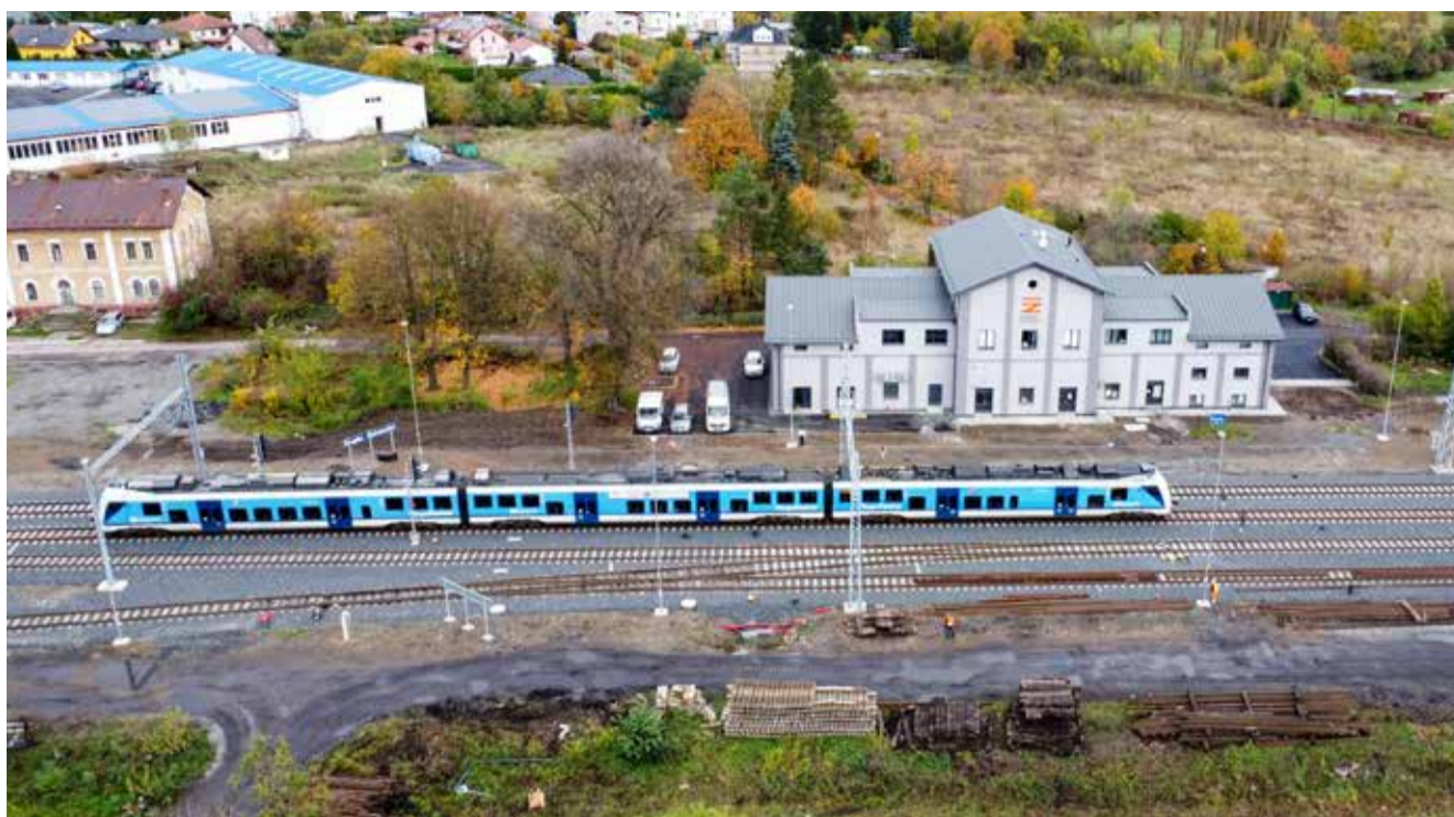
Původní výpravní budova ve stanici Bohosudov byla přestavěna na technologický objekt
