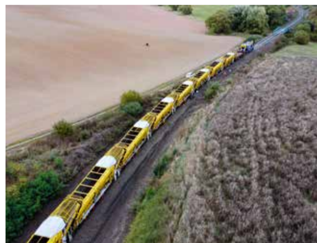
Při opravě trati jsme nasadili těžkou techniku
