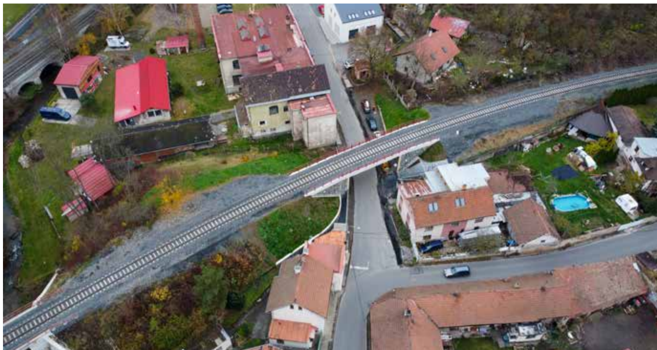
Přibližně čtrnáctimetrové přemostění se nachází v intravilánu obce
