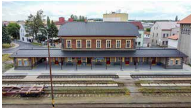
Rekonstrukcí prošlo také nástupiště budovy
