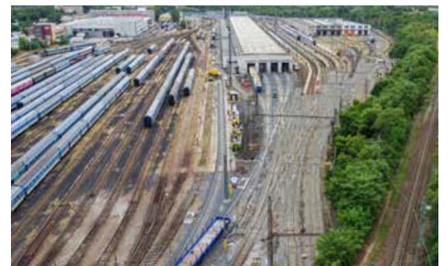
Oprava zajistí provozuschopnost střediska údržby ČD
