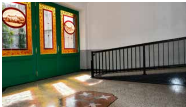
Repase původních vitráží a mozaikových podlah
