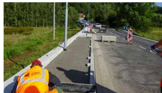
Chodník podrží mohutné záporové pažení
