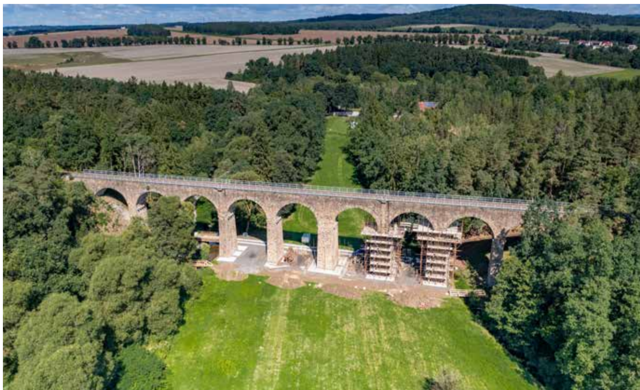
Desetiobloukový kamenný viadukt je postaven z velkých lomových kamenů
