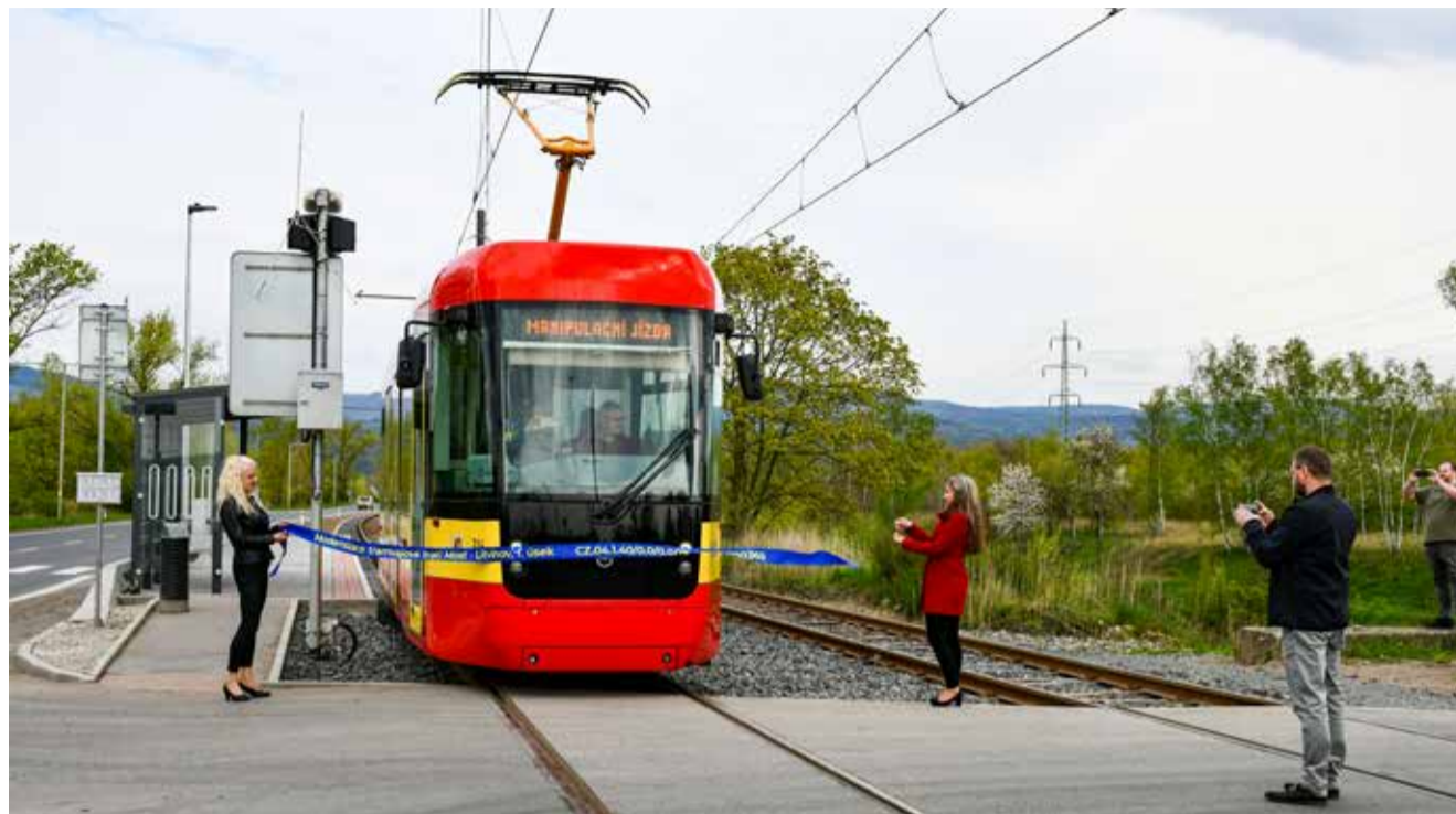
Symbolickým průjezdem páskou byl oficiálně obnoven tramvajový provoz mezi Mostem a Litvínovem
