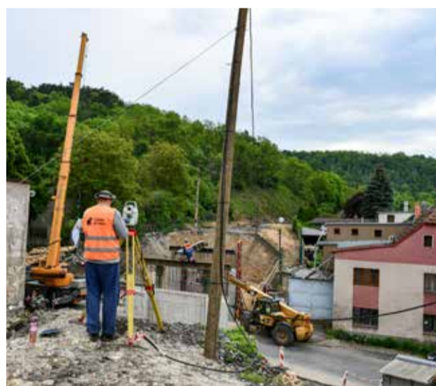
Rekonstrukce přemostění začala v polovině dubna
