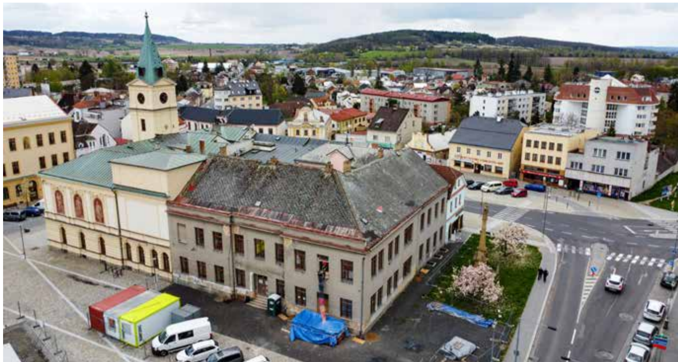
Fasádě objektu vrátíme její historizující, pozdně klasicistní podobu i tři někdejší trojúhelníková průčelí
