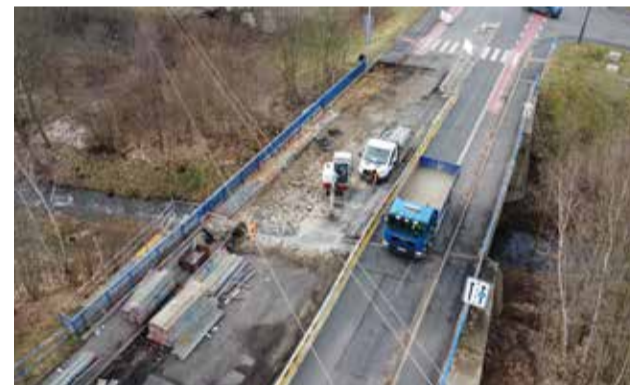
Most převádí dvoupřuhovou silnici přes řeku Bílinu
