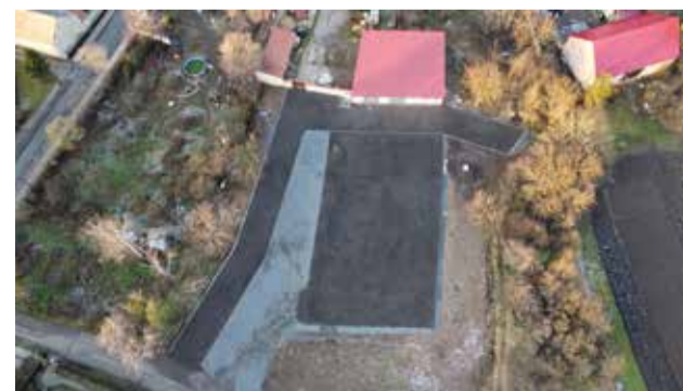
Zpevněná plocha před objektem má rozlohu 960 m 2
