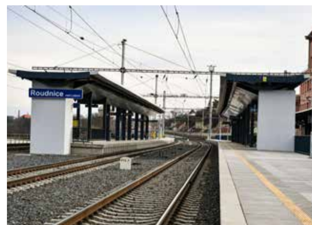
Nástupiště propojuje podchod s výtahy a schodišti
