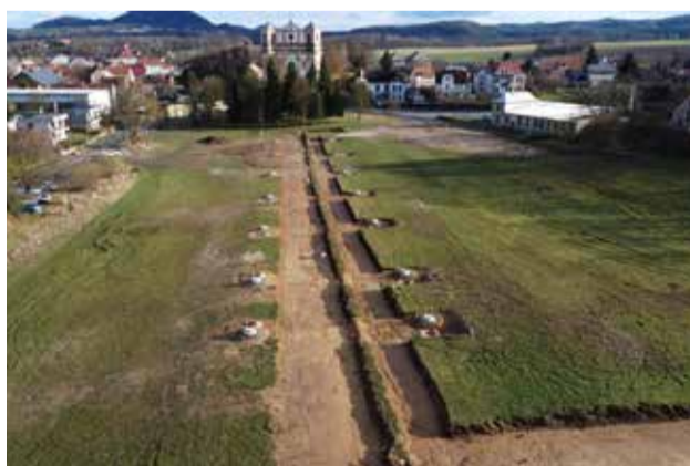
Zasíťovaný pozemek je připraven pro 18 domů
