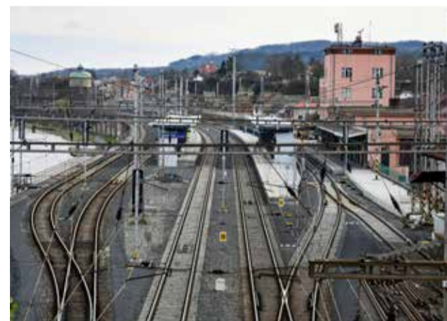
Nové ostrovní nástupiště vzniklo díky redukci kolejí
