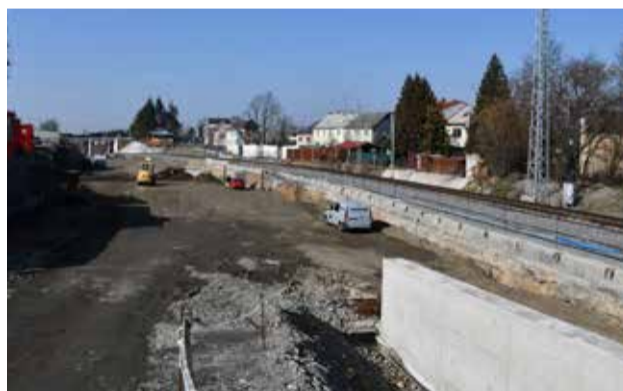
Tunelový zárodek mizí pod zásypem
