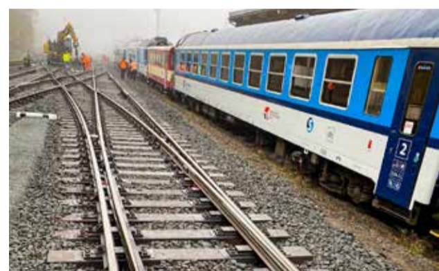
Oprava výhybek a kolejí na hlavním nádraží Trutnov
