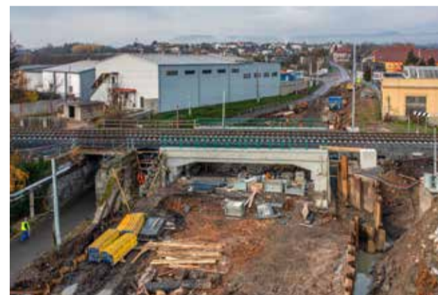
Podjezd pod tratí nahradí původní přejezd
