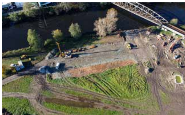
Příprava plochy pro složení a usazení mostu
