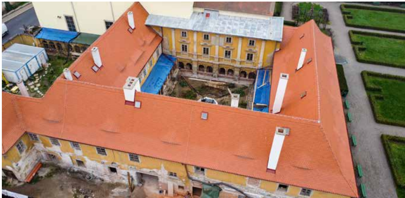
Pomalou, ale přece postupuje rozsáhlá rekonstrukce památkově chráněné čtvercové budovy konventu
