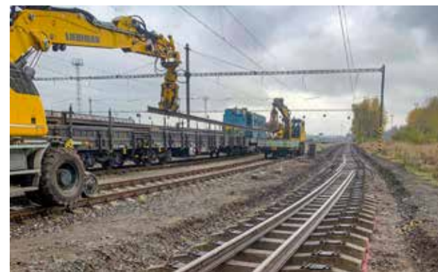
Dvě opravené koleje na seřazovacím nádraží
