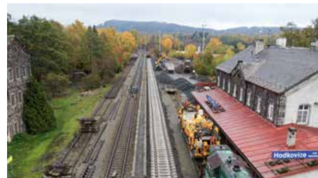
Opravené staniční koleje v Hodkovicích n/M
