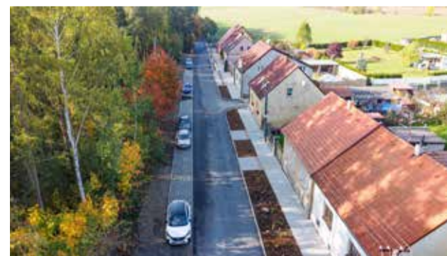
Komunikace ze Srbů do Kačic po rekonstrukci
