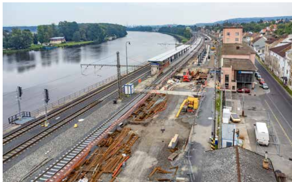
IMPROVIZACE. Ke třetímu nástupišti je zřízen dočasný úrovnňový přechod přes provozované kolejistiště.
