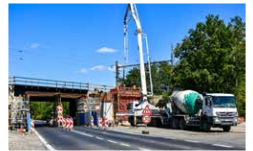
Rekonstrukce mostu v Soběchlebech za provozu
