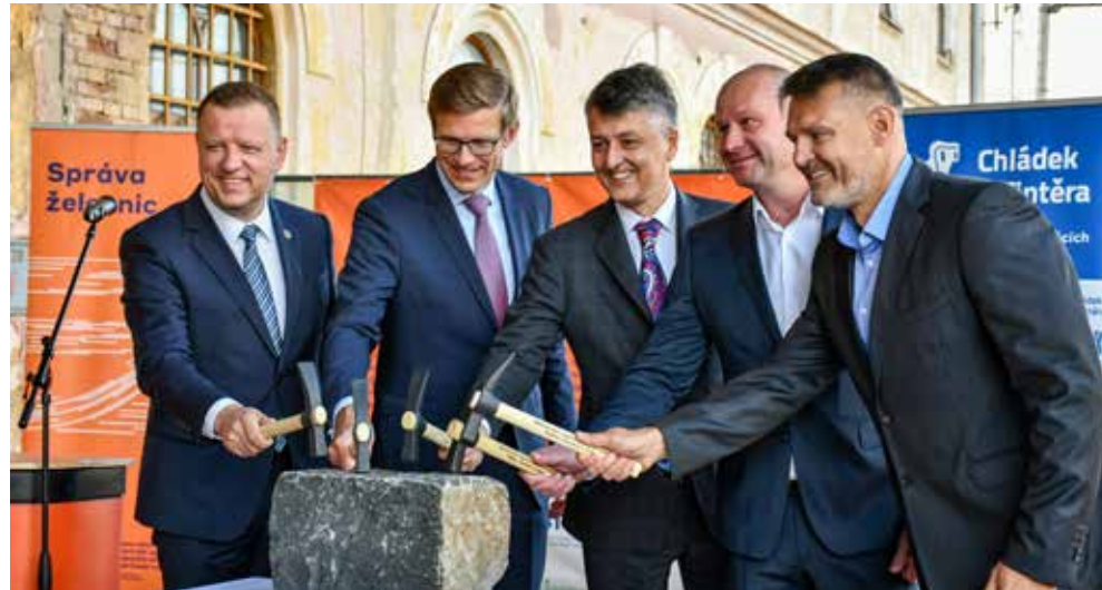
Symbolickým poklepáním základního kamene začala 1. etapa rekonstrukce výpravní budovy Teplice v Čechách
