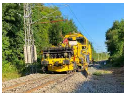
Úprava a doplňování štrku strojem USP 2000 C2
