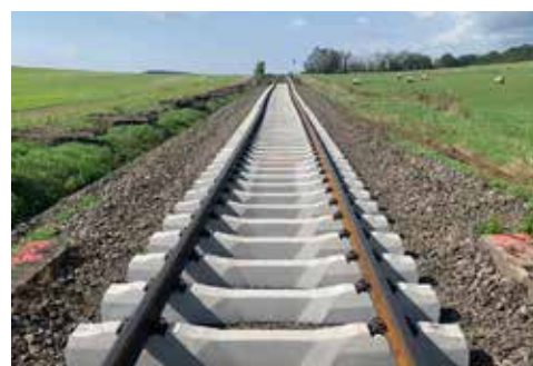
Oprava svršku na 3,5 km dlouhém úseku trati
