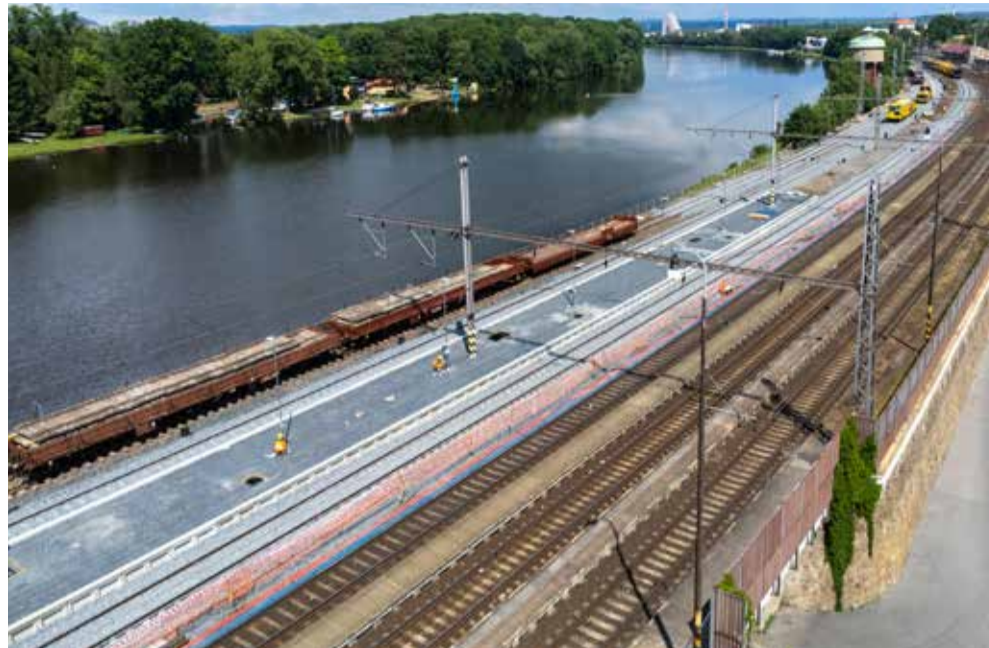
2 KM KOLEJÍ. Během první etapy stavaři zrekonstruovali sudou skupinu kolejí, kterou tvoří celkem tři koleje.
