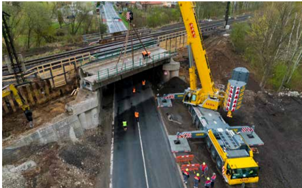
UZAVÍRKA SILNICE I/13. Snášení dvou železobetonových předpjatých nosníků během velikonočního víkendu.
