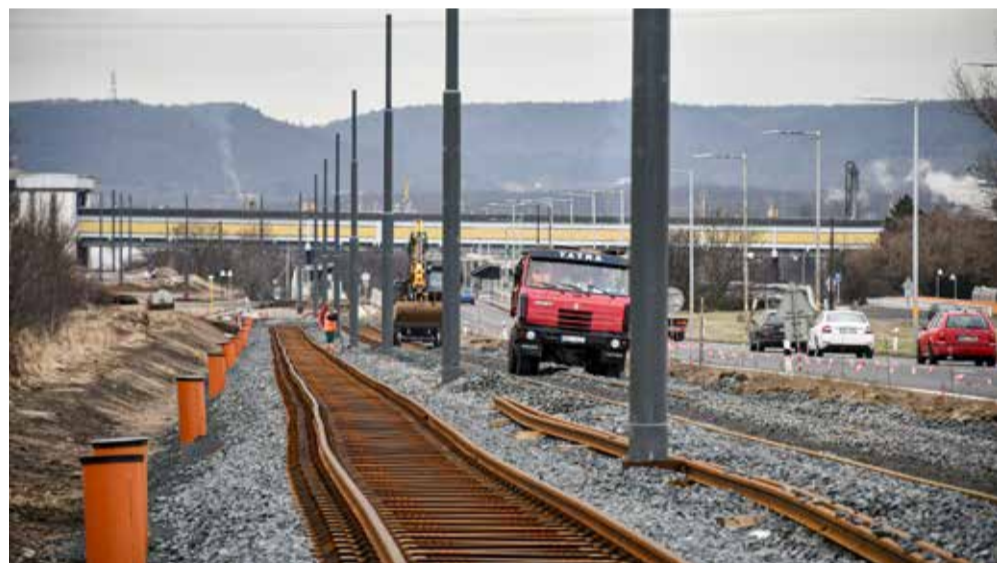
PRVNÍ STOVKY METRŮ. Pokládka nových kolejí začala od nádraží v Litvínově směrem k Záluží.
