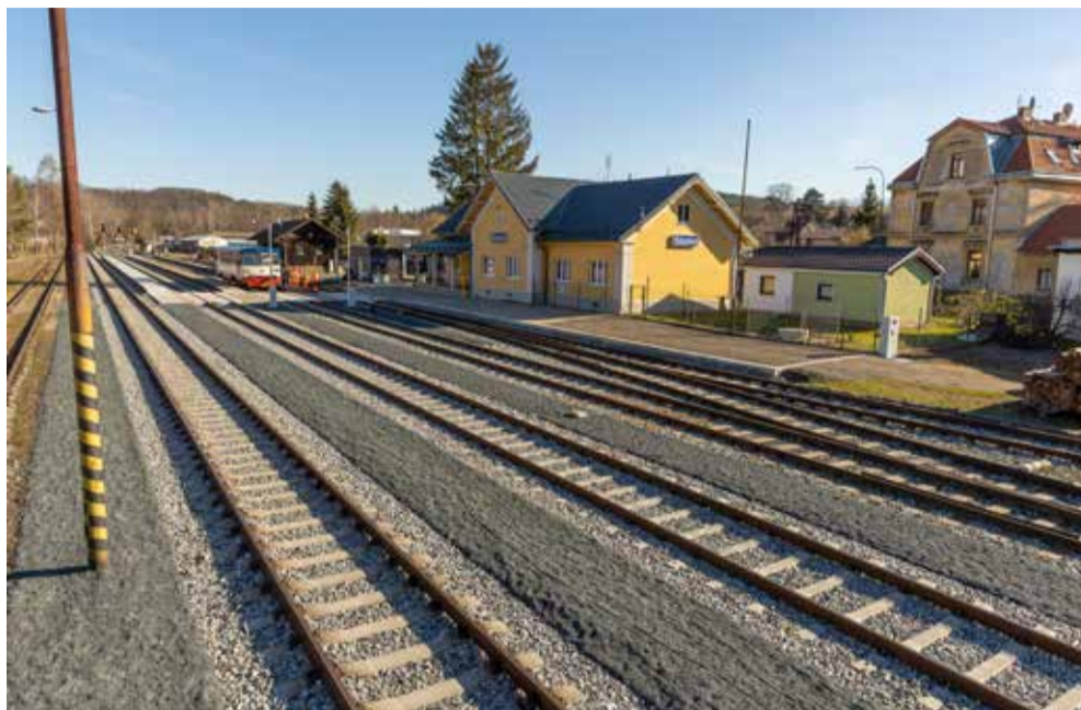
1,5 KM KOLEJÍ. Ve stanici Sázava jsou kompletně zrekonstruované všechny čtyři koleje.
