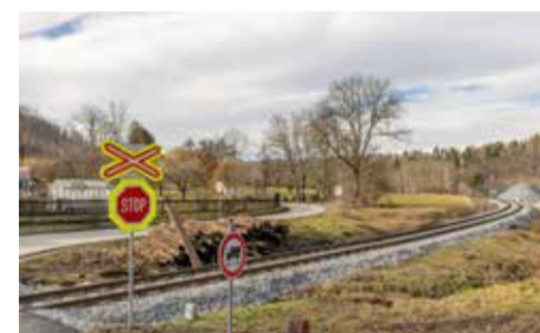
Oprava se dotkla vybraných úseků trati č. 212
