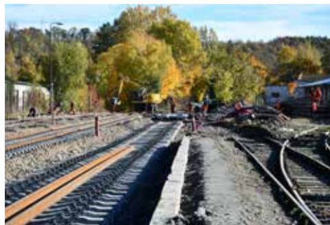
Opravné práce ve stanici Sázava
