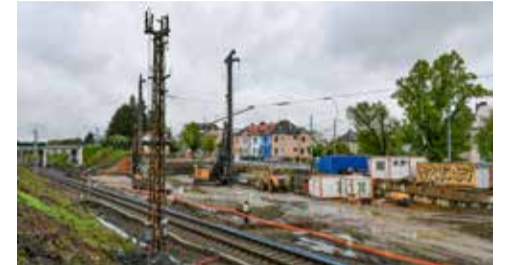
Příprava tunelu pro přeložku silnice I. třídy I/20
