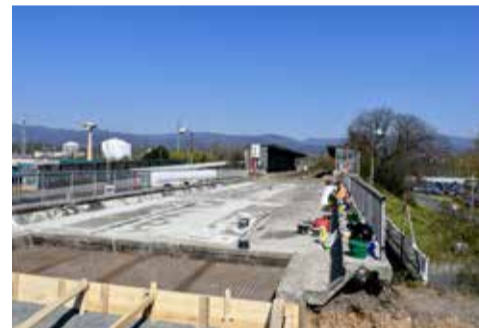
Oprava se týká také několika mostů na trati
