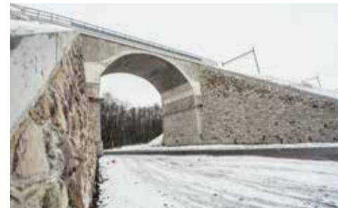
Dokončená oprava mostu přes místní komunikaci
