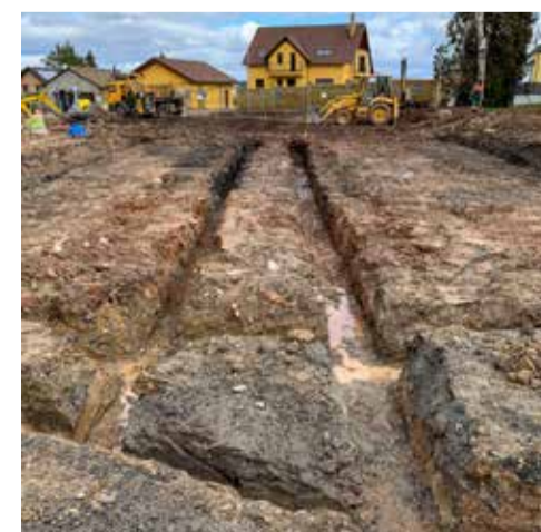
Základové pasy budoucího pavilonu školky
