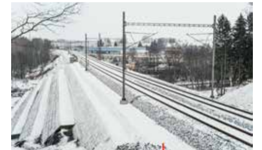
Zrekonstruované těleso u Dalovic
