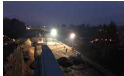
Práce na tělese násypu v nočních hodinách
