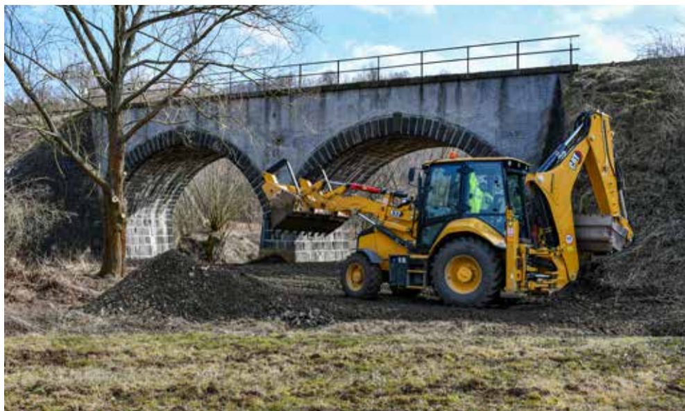
2 KILOMETRY. Přípravné práce spočívají především ve zřízení příjezdových cest.
