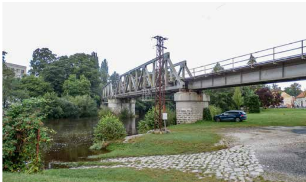
56 DNÍ. Hlavní oprava mostu bude provedena ve výluka, která bude trvat skoro dva měsíce.
