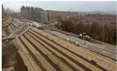
Dokončený násyp ze systému „Green Teramesh“
