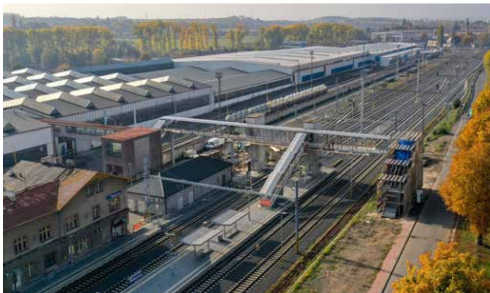
120 + 50 METRŮ. Stávající úrovnňová nástupiště byla nahrazena mimoúrovňovými.
