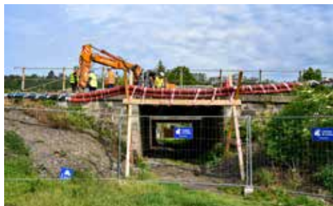
Původní most na začátku stavby
