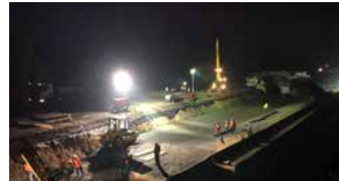
Práce na tělese náspu v nočních hodinách
