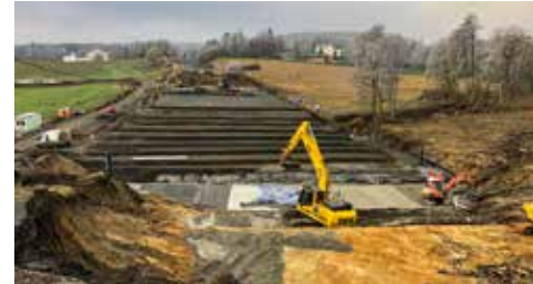
Realizace opravy sesuvu v km 175,850–179,000
