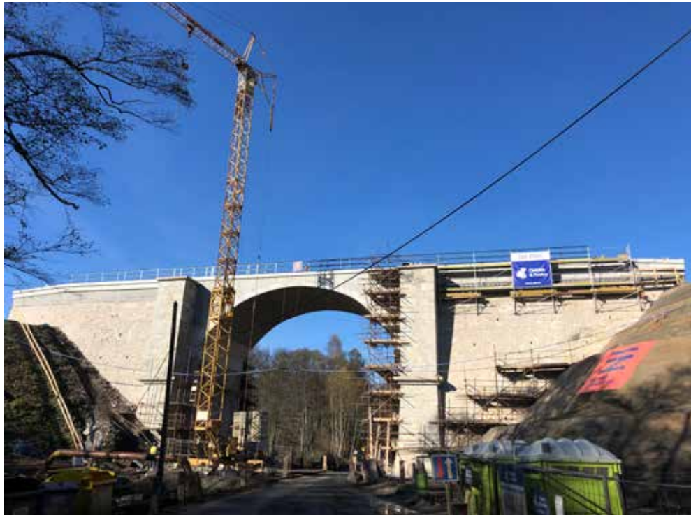
18 METRŮ NAD TERÉNEM. Zrekonstruovaný most přes místní komunikaci a Vitický potok.
