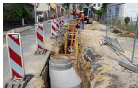
Gravitační kanalizace dosahuje délky téměř 2000 m
