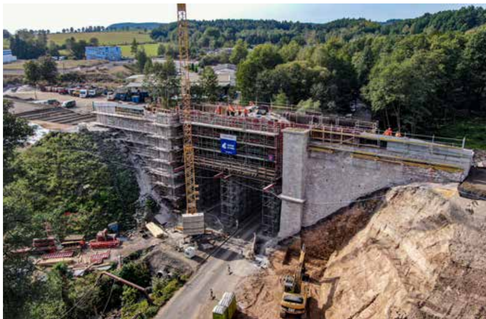
18 METRŮ. Náhrada ocelových nosných konstrukcí probíhá vysoko nad terénem
