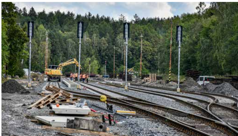
SEDM VÝHYBEK A TŘI KOLEJE. Dohromady bylo vloženo více než 3000 pražců a tři kilometry nových kolejnic
