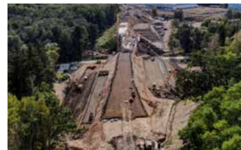
Stabilizace tělesa v místě sesuvu
