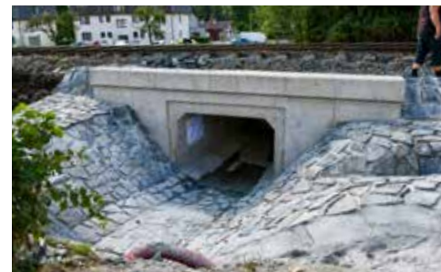
Nový mostek z železobetonového rámu
