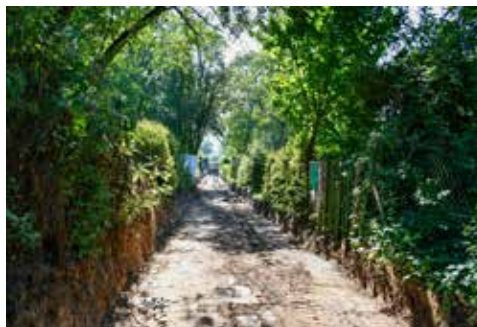
Zemní práce brzdily nalezené inženýrské sítě
