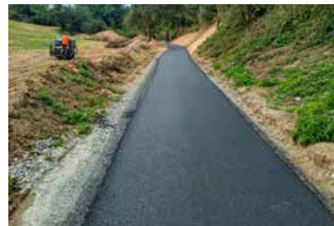
V září již začala pokládka asfaltových vrstev
