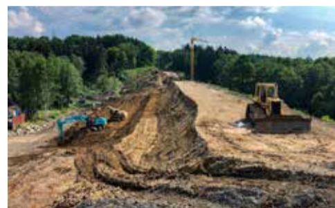
Práce na sanaci náspu začaly
