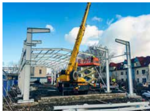
Montáž haly začala v únoru, betonáž základových patek byla provedena na sklonku loňského roku
