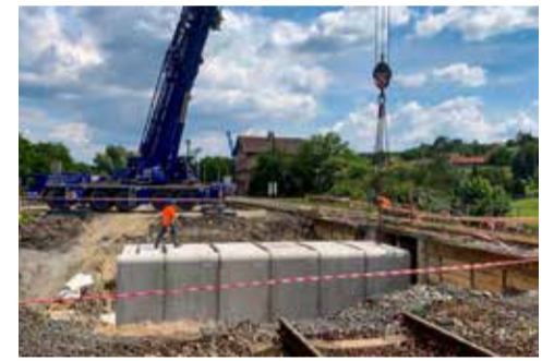
Konstrukci budou tvořit železobetonové rámy
