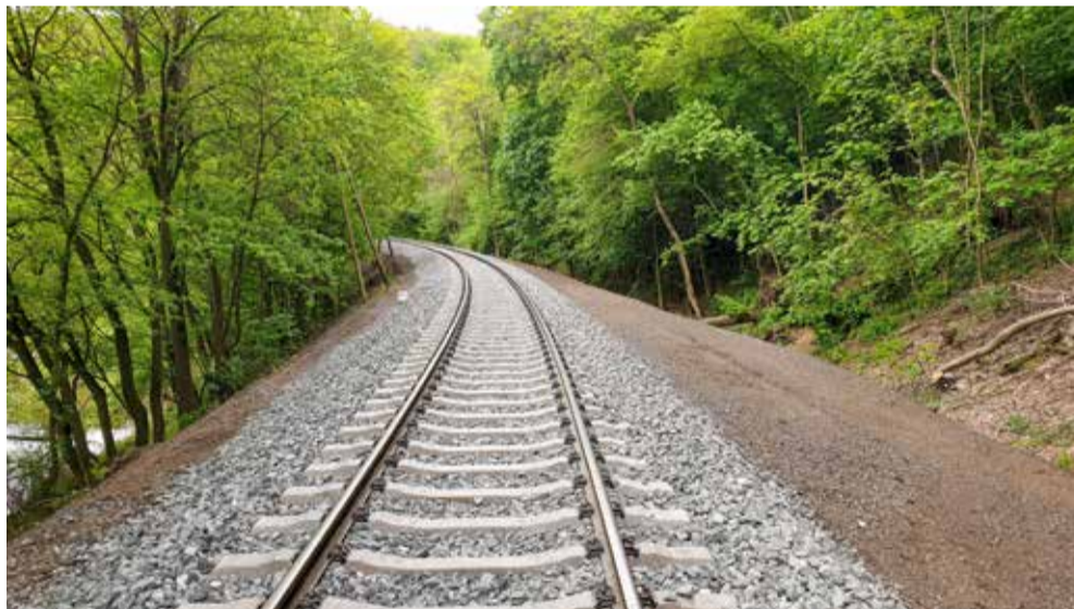
ČTYŘI TISÍCE NOVÝCH PRAŽCŮ. Hlavní penzum prací spočívalo ve výměně pražců a částečně i kolejnic
