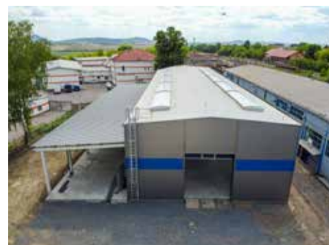
Mezi moderní výrobní zařízení bude patřit mimo jiné i plazmový pálicí stůl
