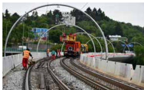
Na estakádě byla provedena oprava mostních závěrů
