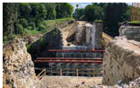
Příprava pro novou konstrukci mostu
