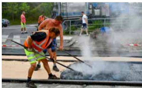
Rekonstrukce se dotkla dvou přejezdů
