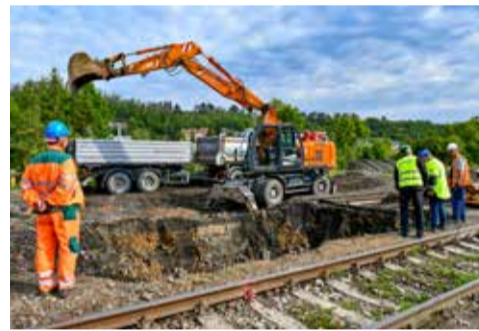
Rekonstrukce mostu začíná pod 1. a 3. kolejí
