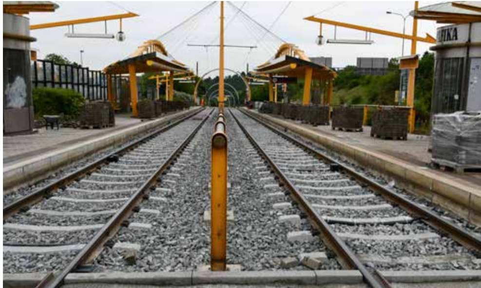
FINÁLNÍ ÚPRAVA. Nový tramvajový svršek tvoří bezстыková kolej s předepsanou geometrickou polohou
