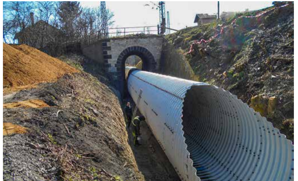
PRŮMĚR 2,7–3,4 M. Do mostu se vsune a zabetonuje ocelová flexibilní konstrukce vejčitého tvaru.
