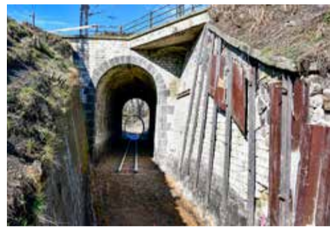
Nejprve bylo nutné zajistit rozpadlé mostní křídlo
