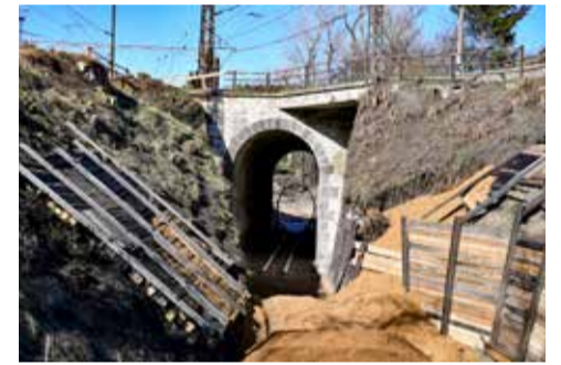
Během zajišťovacích prací se část svahu sesula
