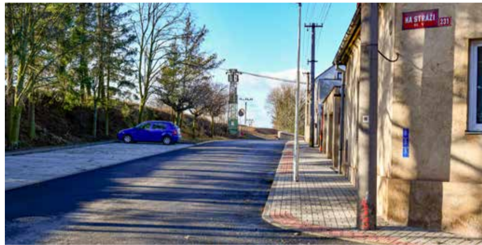
ŠÍŘE VOZOVKY 5,5 METRU. Hlavní místní komunikace je dvoupruhová s chodníkem a dvěma parkovišti.
