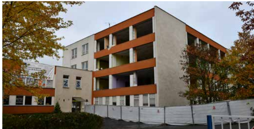
HRUBÁ STAVBA. Do příchodu zimy stavbaři plánují objekt stavebně uzavřít a dokončit vnitřní dispozice.
