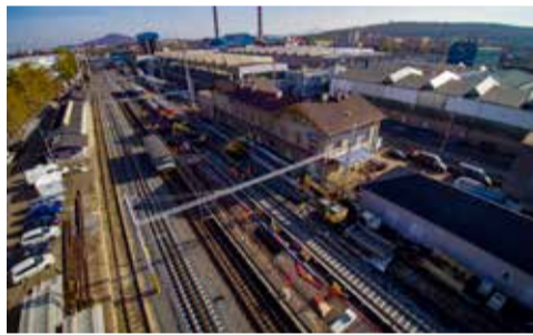
Práce ve stanicích Řetenice
