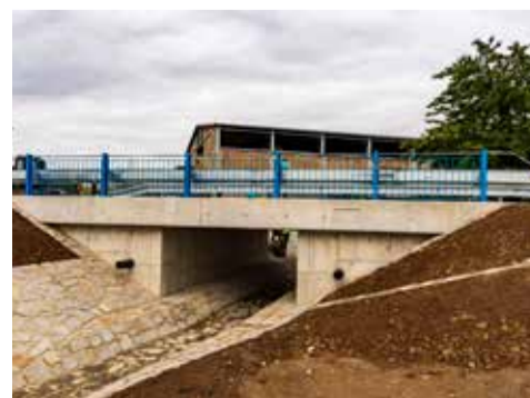
Most je založen na velkopřůměrových pilotách
