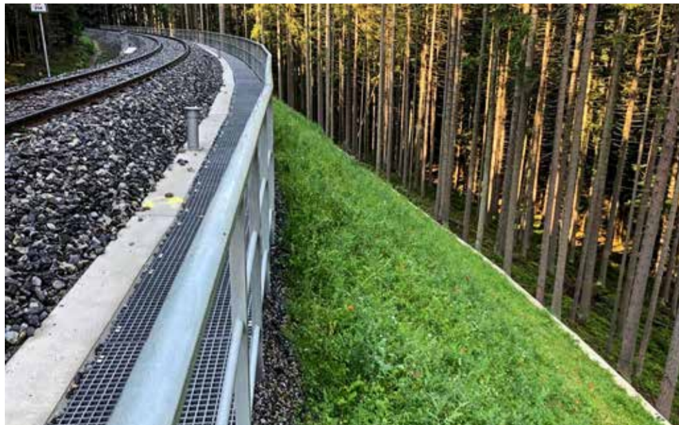
Finální dokončení projektu včetně stabilizace koruny náspu v délce asi 200 metrů
