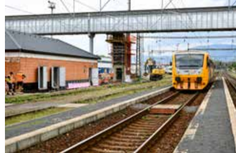
Nový technologický objekt a základy výťahu
