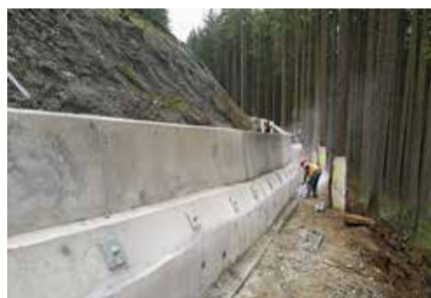
Dokončená opěrná zeď – listopad 2018
