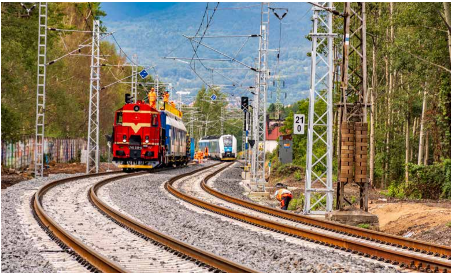
Po rekonstrukci dvoukolejné trati z Řetic směřem do Oldřichova u Duchcova se práce přesouvají do stanice v Řetenicích
