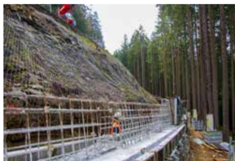
Výstavba opěrné zdi u paty náspu – říjen 2018
