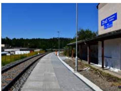
Opravená zastávka ve Zruči n/S
