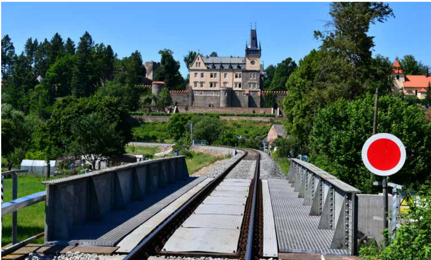
Třicetkilometrová oprava trati začínala v Ledečce a končila před stanicí ve Zruči nad Sázavou (viz obrázek)
