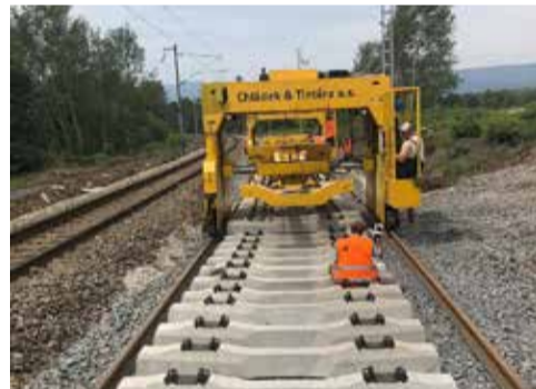
Donelli při modernizaci trati směrem do Oldřichova
