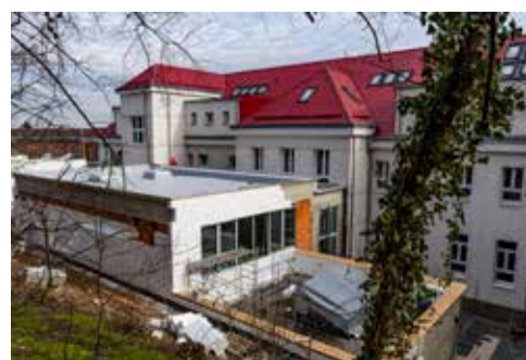
Přístavba se přimyká ke svahu za budovou školy
