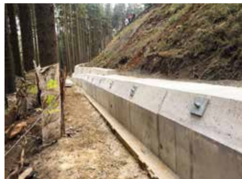
Masivní železobetonová zeď u paty náspu jistí svah proti dalšímu sesunu
