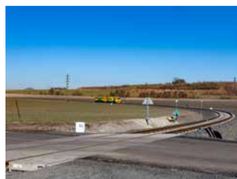
Zrekonstruovaný úsek trati Louny–Lovosice
