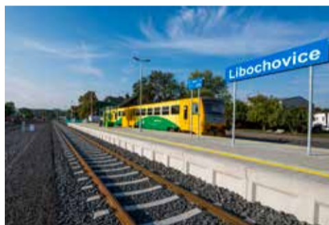
Stanice Libochovice po rekonstrukci
