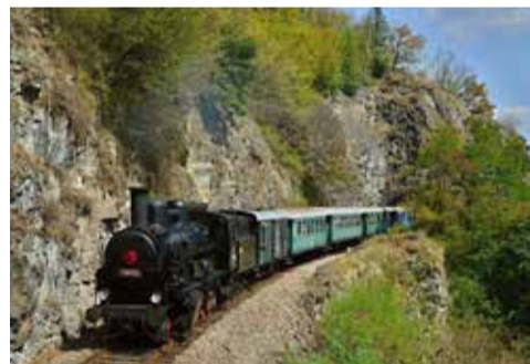
Podél trati dojde k četným sanacím skal
