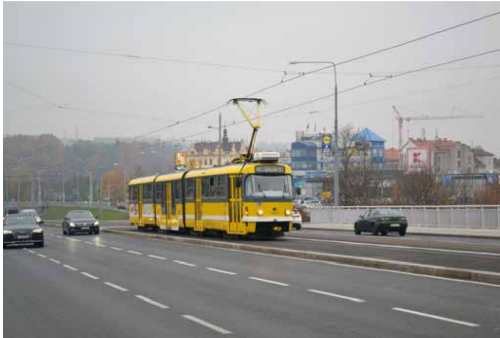
HOTOVO. Závod kolejových staveb na mostě vybudoval obě pevné jízdní dráhy typu W-tram pro tramvaje.
