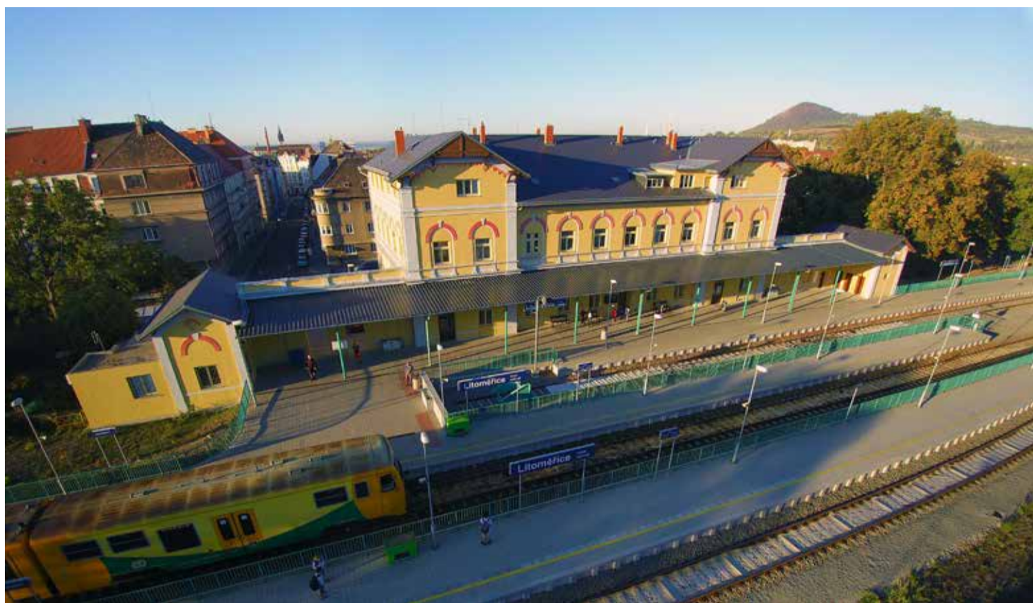
10. července 2018 byla dokončena rekonstrukce výpravní budovy. Po 120 letech od otevření vypadá opět jako nová.
