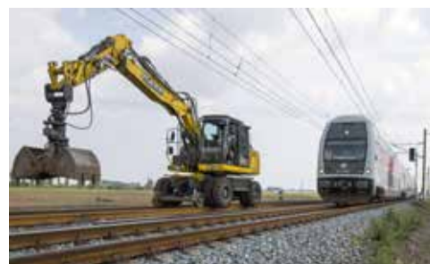
ČÁSTEČNÝ PROVOZ. Oprava sedmi kilometrů kolejí probíhá za provozu na sousední koleji.
