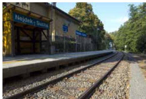
Zastávka Nejdeček-Suchá s novým nástupištěm
