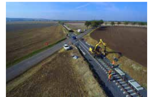
NOVÉ NÁSTUPIŠTĚ. Ve stanici Libochovice vzniklo ostrovní nástupiště s bezbariérovým přístupem a kolejové uspořádání. Jinde se již pokládá železniční svršek.
