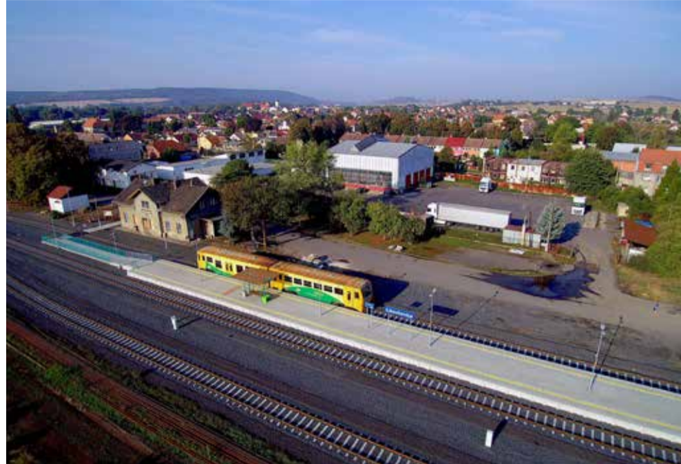
NOVÉ NÁSTUPIŠTĚ. Ve stanici Libochovice vzniklo ostrovní nástupiště s bezbariérovým přístupem a kolejové uspořádání. Jinde se již pokládá železniční svršek.
