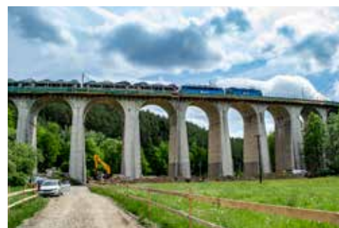
Pohled na velký viadukt v Kutinách
