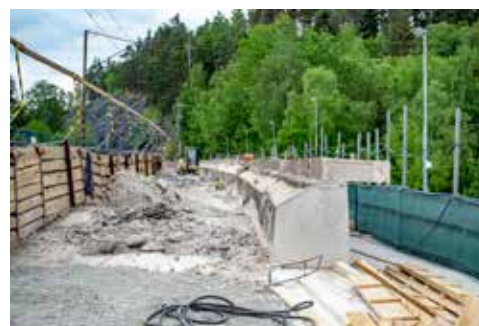
Rozšíření velkého viaduktu v Kutinách
