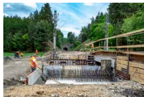
Sanace mostu u Níhovského tunelu
