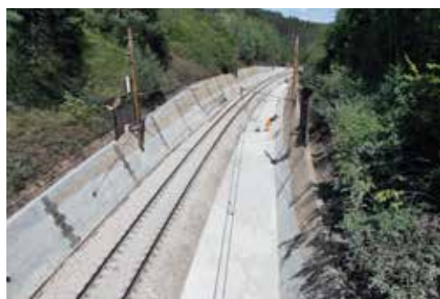
HOTOVO ZATÍM 20 PROCENT. Loni byly dokončeny sanace betonových zárubních zdí, stožáry trakčního vedení a několik mostů a propustků
