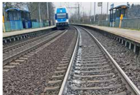
Utržený vagon poničil pražce a prvky žel. svršku
