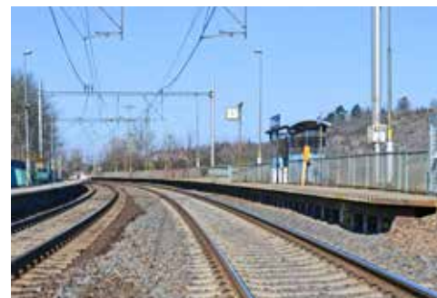
Za necelých 20 dní byla kolej opět v provozu
