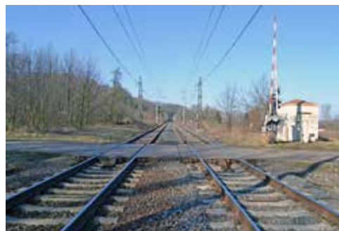
Opraveny musely být také dva žel. přejezdy
