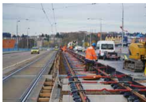
SYSTÉM W-TRAM. Pevná jízdní dráha s upevněním W-tram se buduje odshora dolů – nejprve se umístí kolejový rošt a teprve poté se koleje podbetonují
