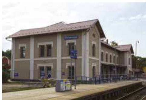
Opravená výpravní budova v Neratovicích
