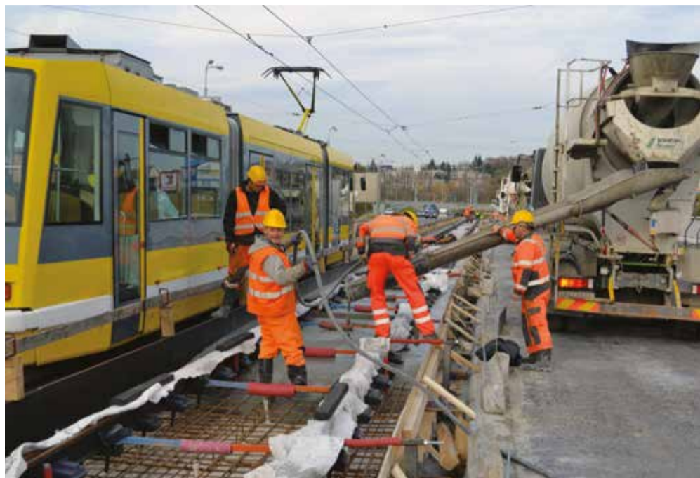
SYSTÉM W-TRAM. Pevná jízdní dráha s upevněním W-tram se buduje odshora dolů – nejprve se umístí kolejový rošt a teprve poté se koleje podbetonují
