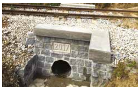
Most na trati Břežnice–Strakonice
