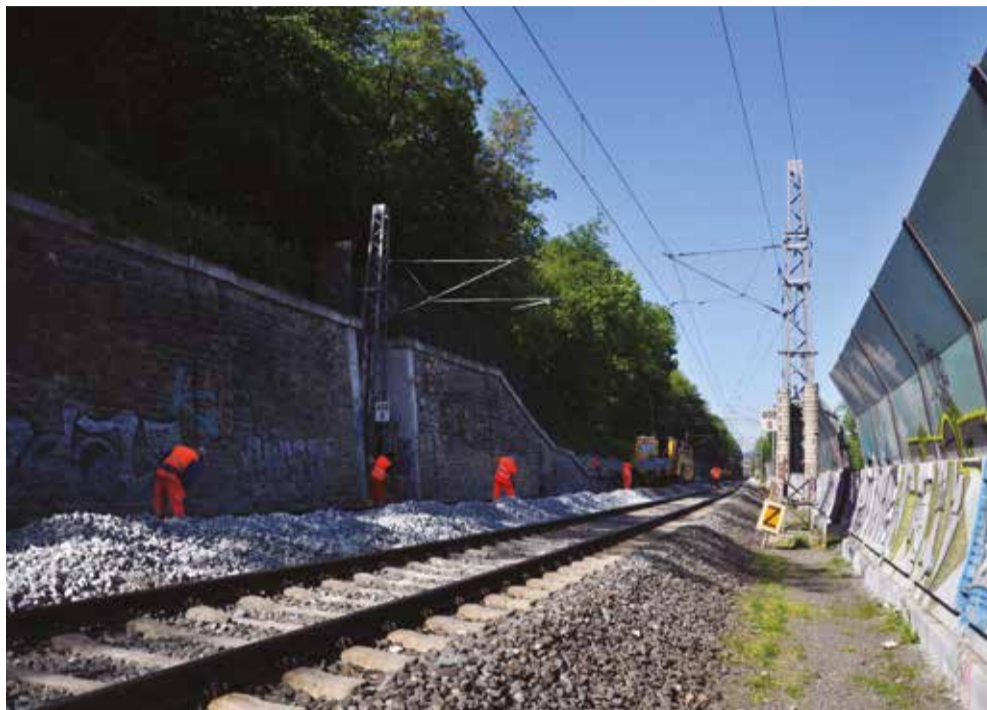
DVĚ ETAPY. V každé bude zrekonstruován železniční spodek jedné z kolejí, v součtu asi 240 metrů.
