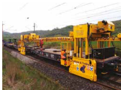
Na trati Řehlovice–Úpořiny závod kolejových staveb prováděl sanaci železničního spodku
