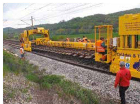
Na trati Řehlovice–Úpořiny závod kolejových staveb prováděl sanaci železničního spodku
