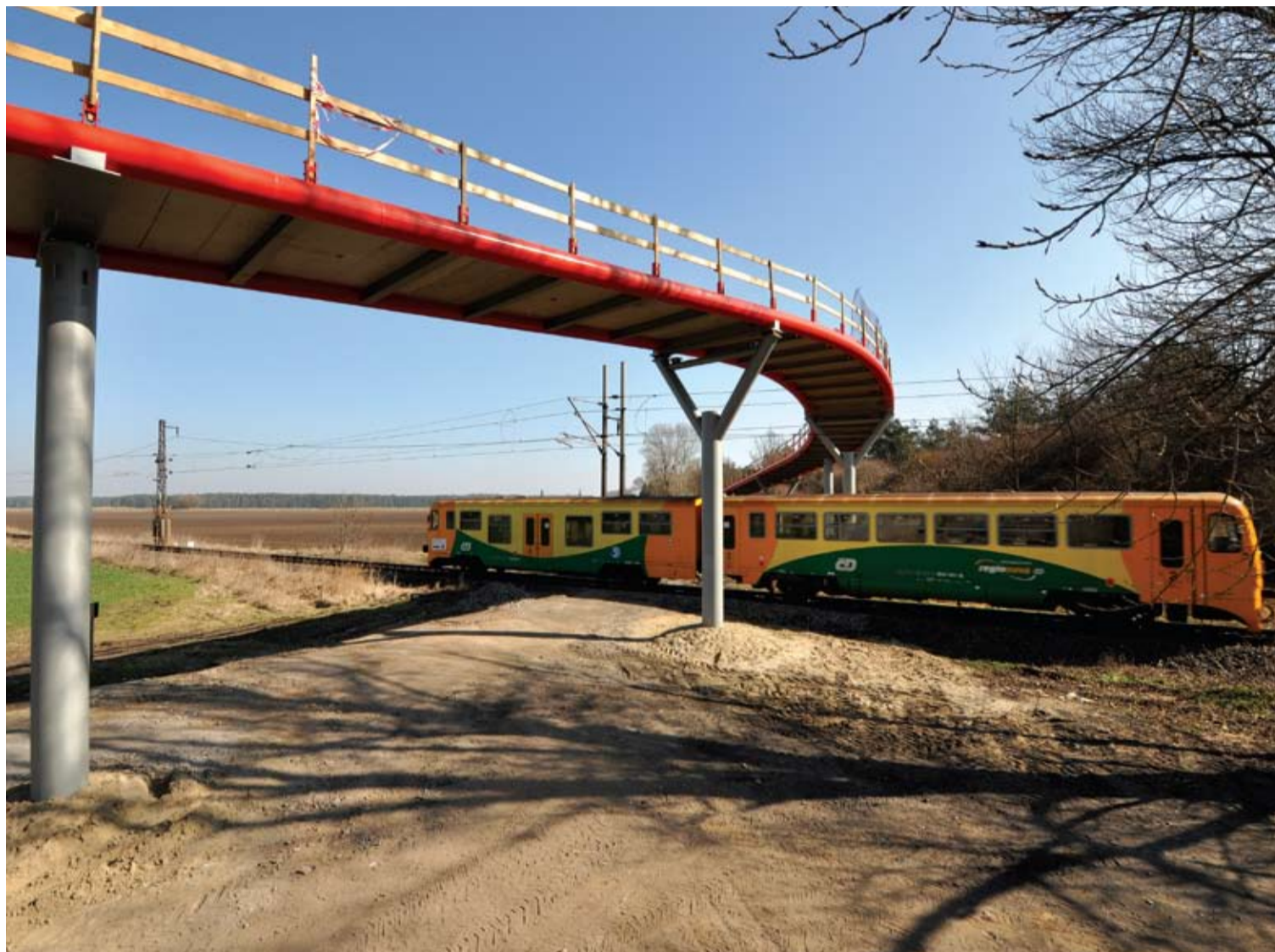
STAVBA ROKU. Unikátní přemostění trati cyklostezkou na sebe poutá pozornost. Rodí se i návrhy na titul Stavba roku.
