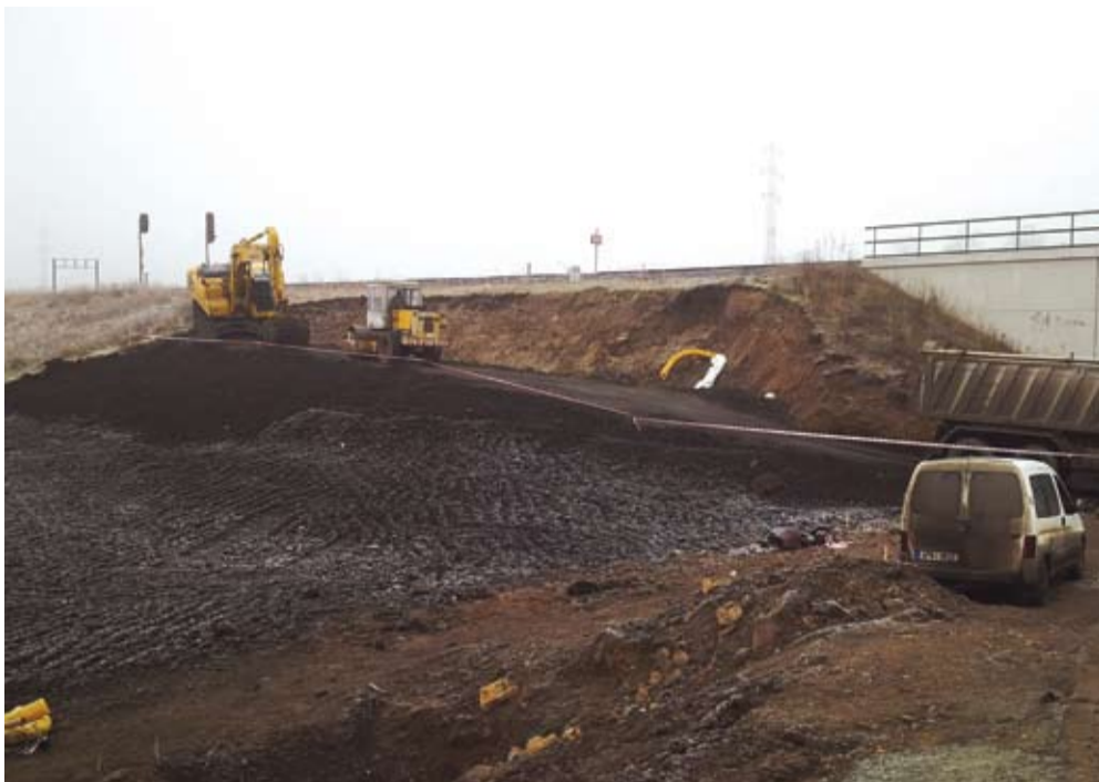
UTRŽENÝ NÁSEP. Stavbaři odtěžili nestabilní zeminu a hutněním vybudovali nový násep. Foto: M. Nehyba
