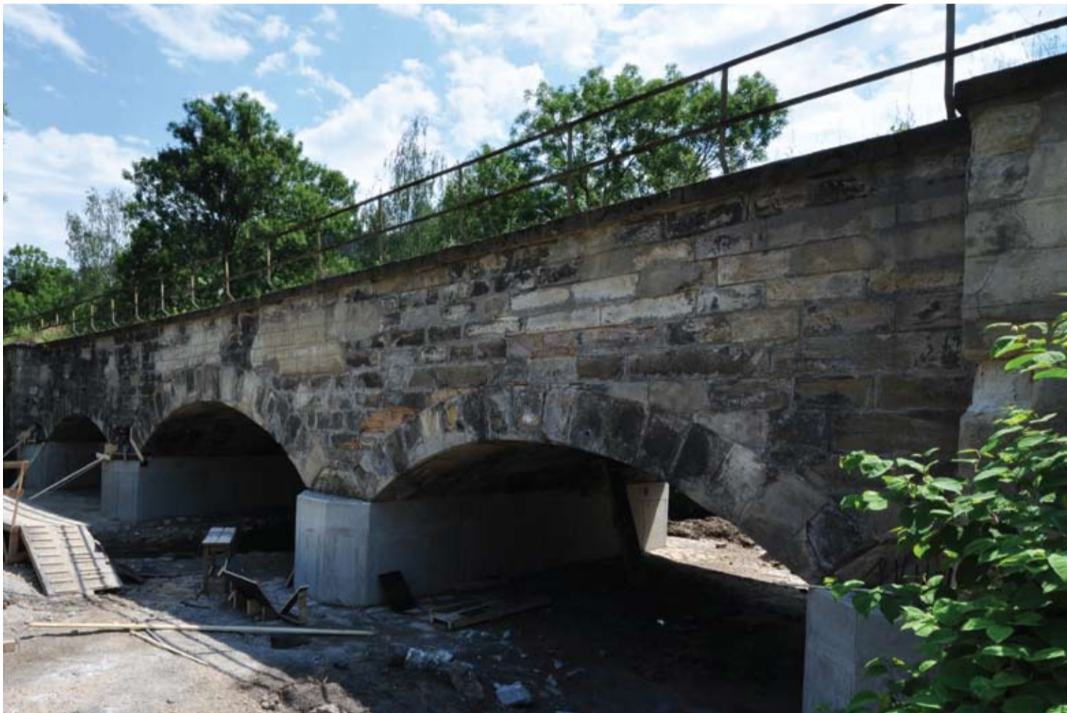
POD VODOU. Třípolový most převádí železnici přes Zákolanský potok, který je známý častým rozvodněním.
