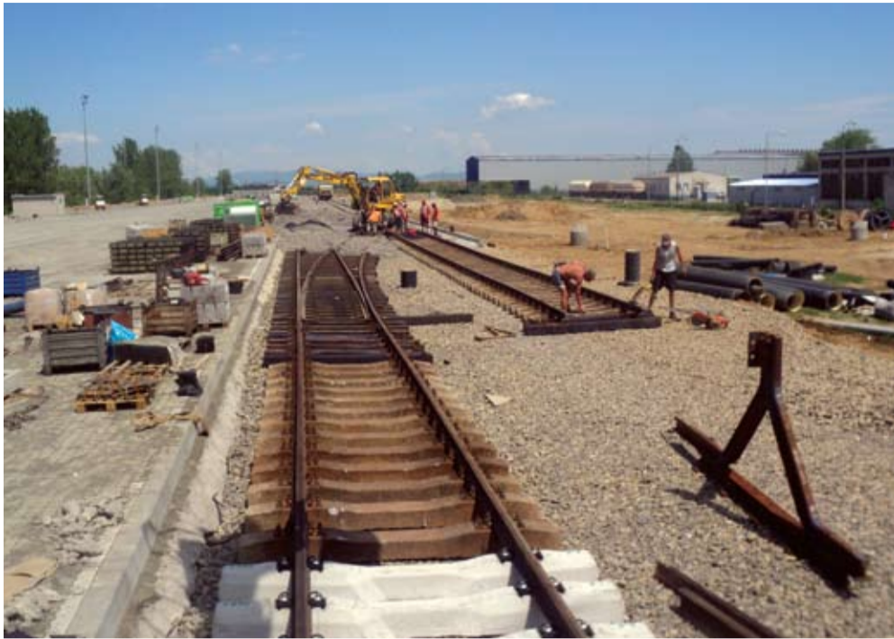
HANISKA. Kolejářů položili na připravené zemní pláni 1300 metrů kolejí pro vlečku. Foto: Pavel Jakoubek
