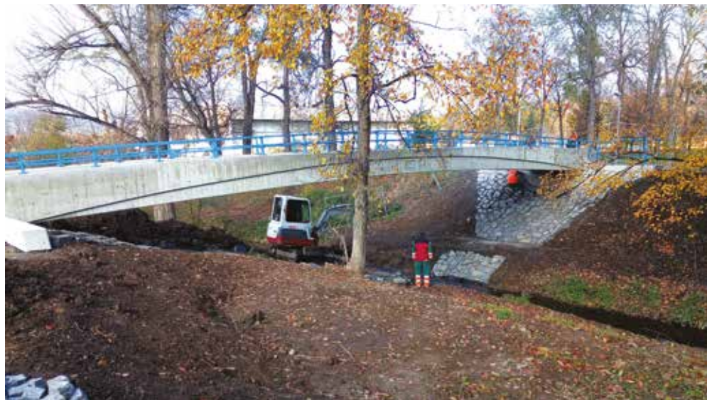
SAMOVÝROBA. Čtyřiadvacetimetrová monolitická trámová konstrukce vznikla na místě.
