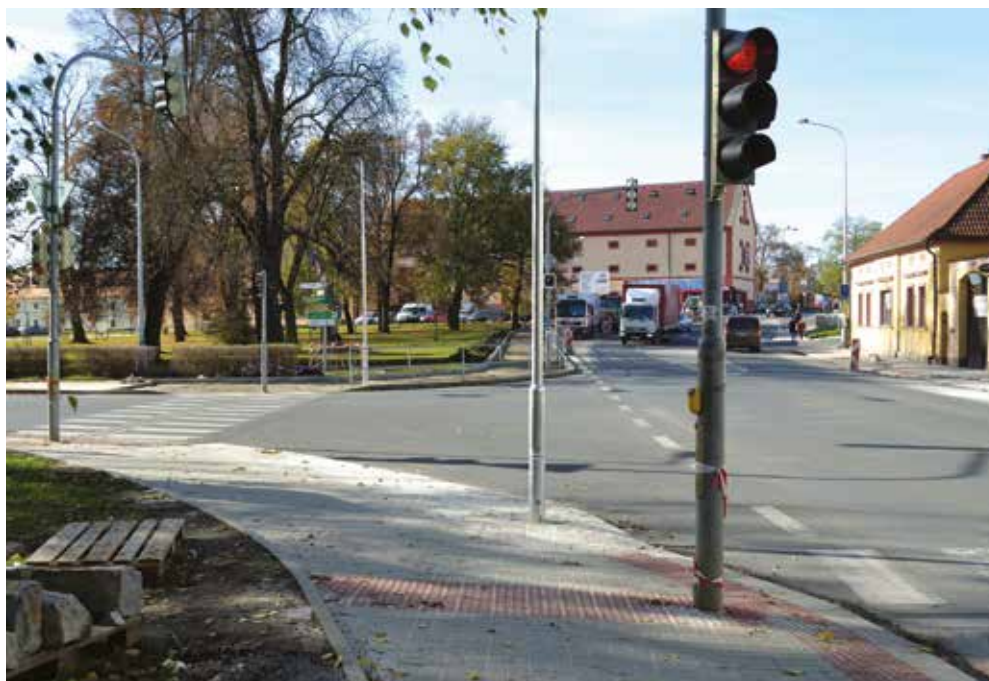
ŽÁDNÉ OMEZENÍ DOPRAVY. Nejnáročnější byla rekonstrukce chodníků přímo v centru Hostivic, kde je málo prostoru a silnici stavbaři nemohli v žádném případě blokovat.
