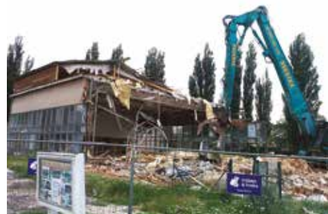
Demolice původní tělocvičny netrvala dlouho
