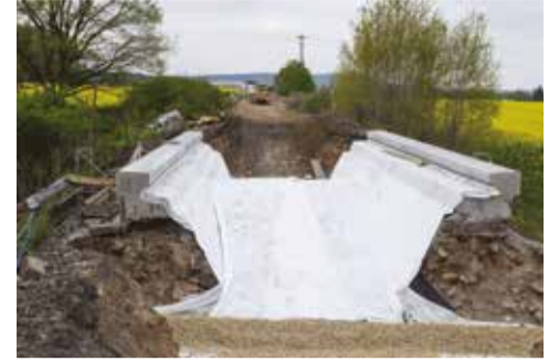
Mostaři Mirka Běhavyho opravují 19 propustků a kamenný klenbový železniční most přes údolí a vodoteč
