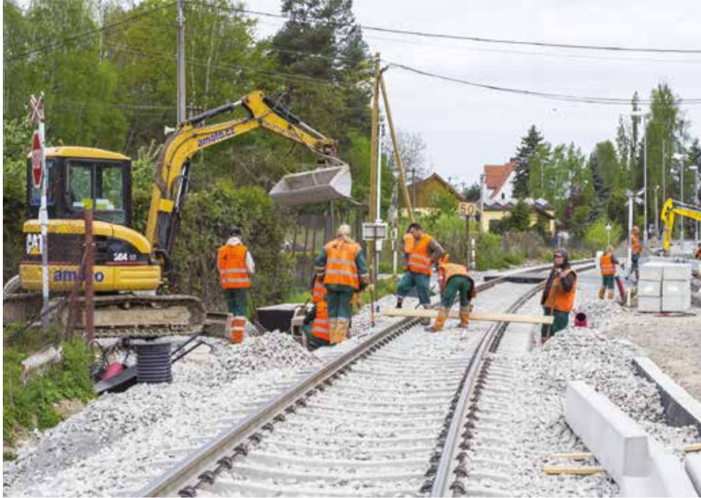
7 KILOMETRŮ. Kolejáři vedení Pavlem Vlčkem nesou hlavní díl prací. Rekonstruují železniční spodek a svršek
