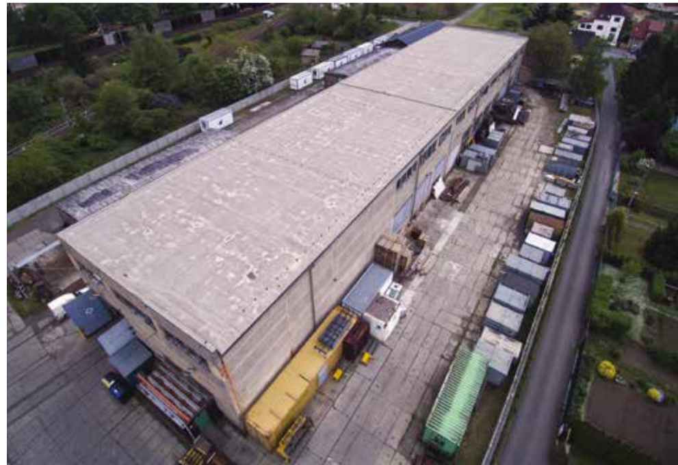
17 500 M 2 . Areál se rozkládá na ploše přibližně 250 x 70 metrů. Stěžejním bodem je velkorozměrová hala
