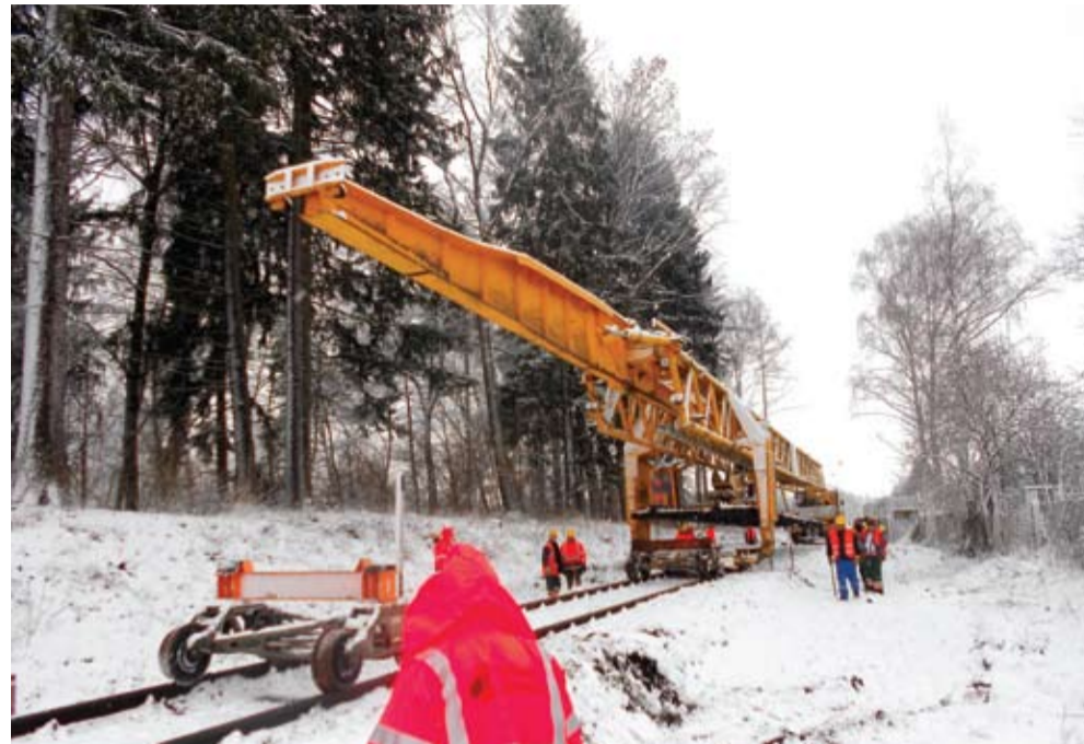
1. BŘEZNA. Pokladač kolejových polí typ PKP 25/20.1H od společnosti GJW poprvé v akci
