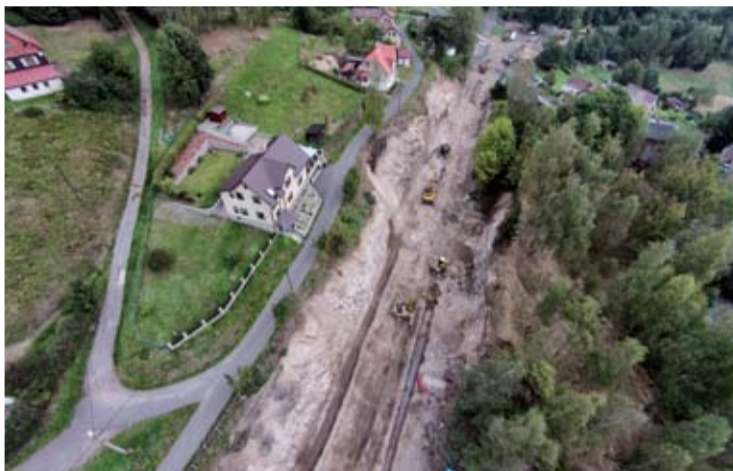
Rekonstrukce železniční stanice Smržovka na trati Liberec-Tanvald
