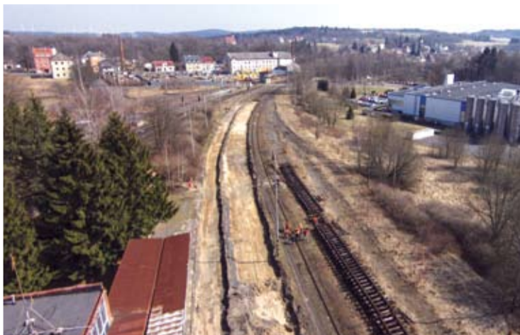
Rekonstrukce trati Aš – státní hranice SRN
