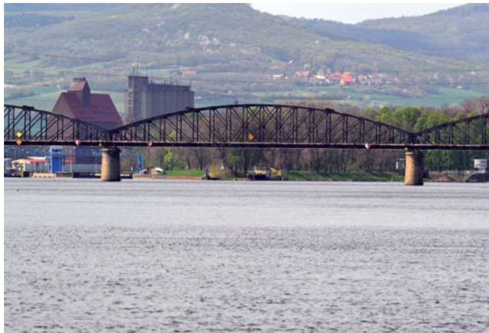
7 POLÍ. Na stávajícím železničním mostě bude vyměněna nosná konstrukce.
