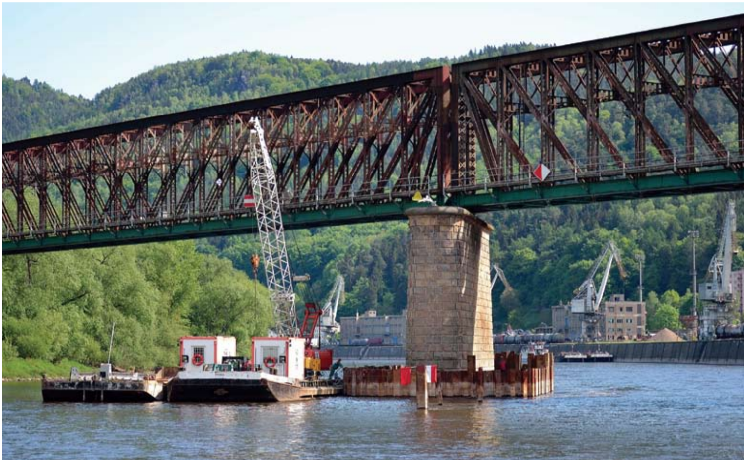
LODNÍ DOPRAVA. K pilíři se dopravují stavbaři i materiály jedinou možnou cestou. Lodí z nedalekého přístavu.
