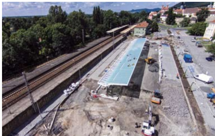
Rekonstrukce autobusového nádraží Litoměřice
