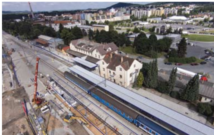
Rekonstrukce železniční stanice Strakonice
