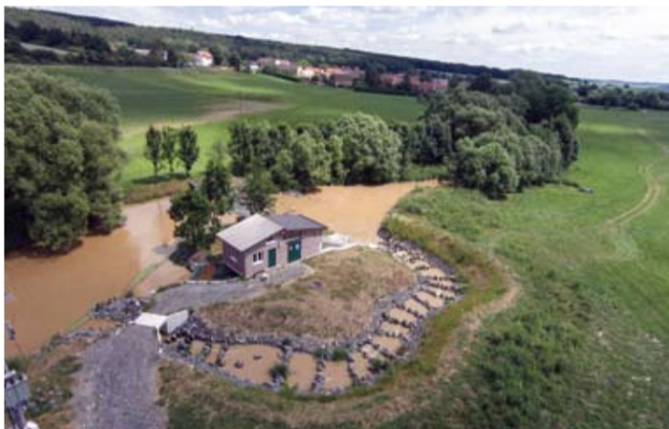
Malá vodní elektrárna s rybím přechodem v Semošicích
