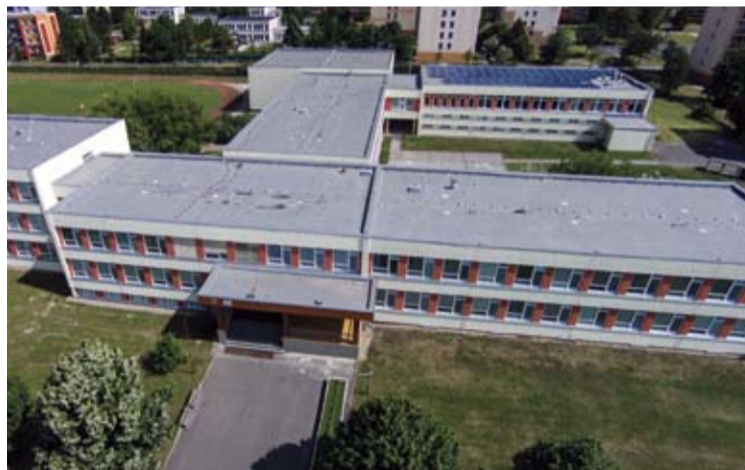
Zateplení základní školy Havlíčkova v Litoměřicích
