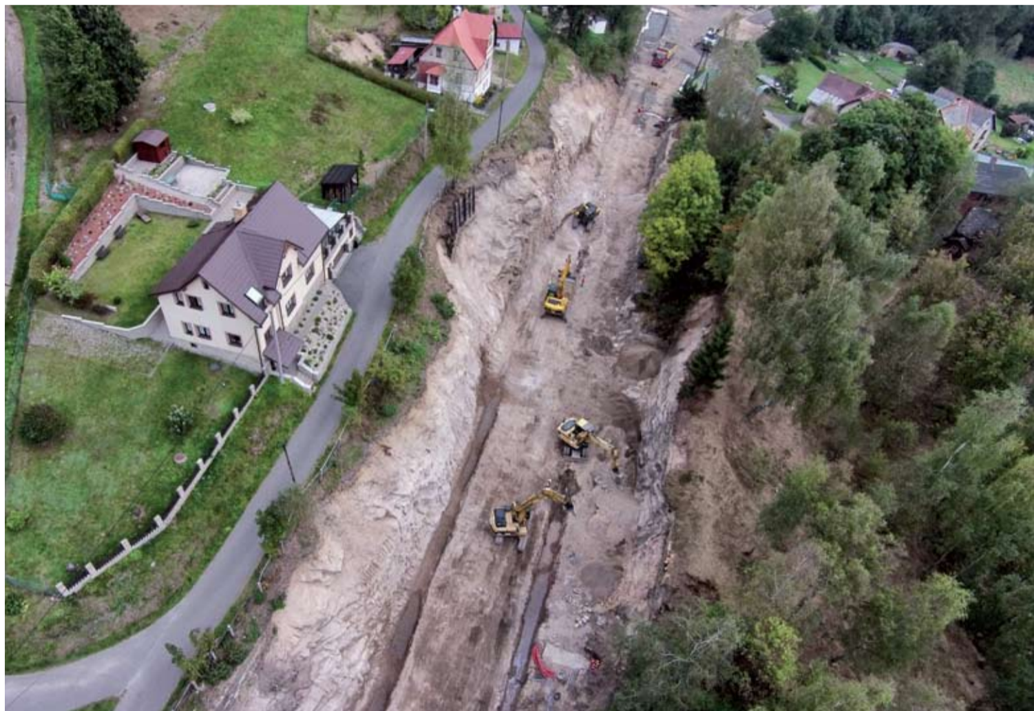
LIBERECKÁ ŽULA. Stavbaři musí ubrousit a odsekat tuny skalního masivu pro nové traťové koleje a odvodnění.
