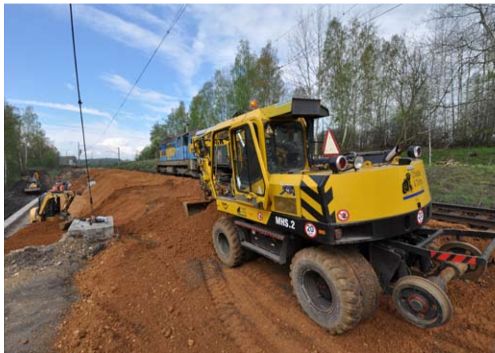
DVĚ STAVBY. Součástí projektu byla také sanace povodněmi uvolněného náspu.
