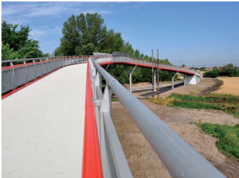
112 METRŮ. Lhotecká cyklostezka je unikátní mostním objektem přes železniční trať. Foto: Pavel Richter
