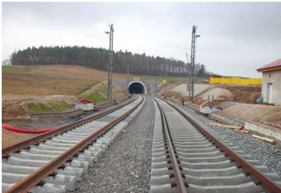
ZAHRADNICKÝ TUNEL. Nejdelší tunel na přeložce vystrojili kolejáři Chládek & Tintěra.
