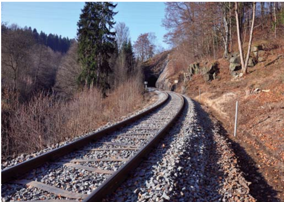
SMRŽOVKA–TANVALD. Trať vede ve skalních zářezích s oblouky o malých poloměrech. Foto: Pavel Richter
