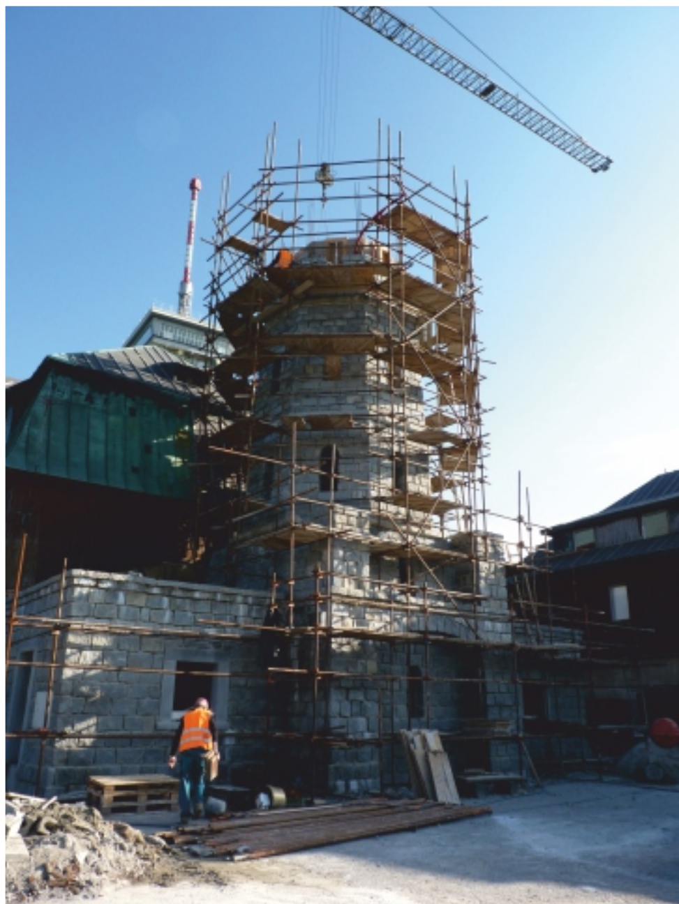
Celkový pohled na rozestavěnou rozhlednu 2.7.2013
