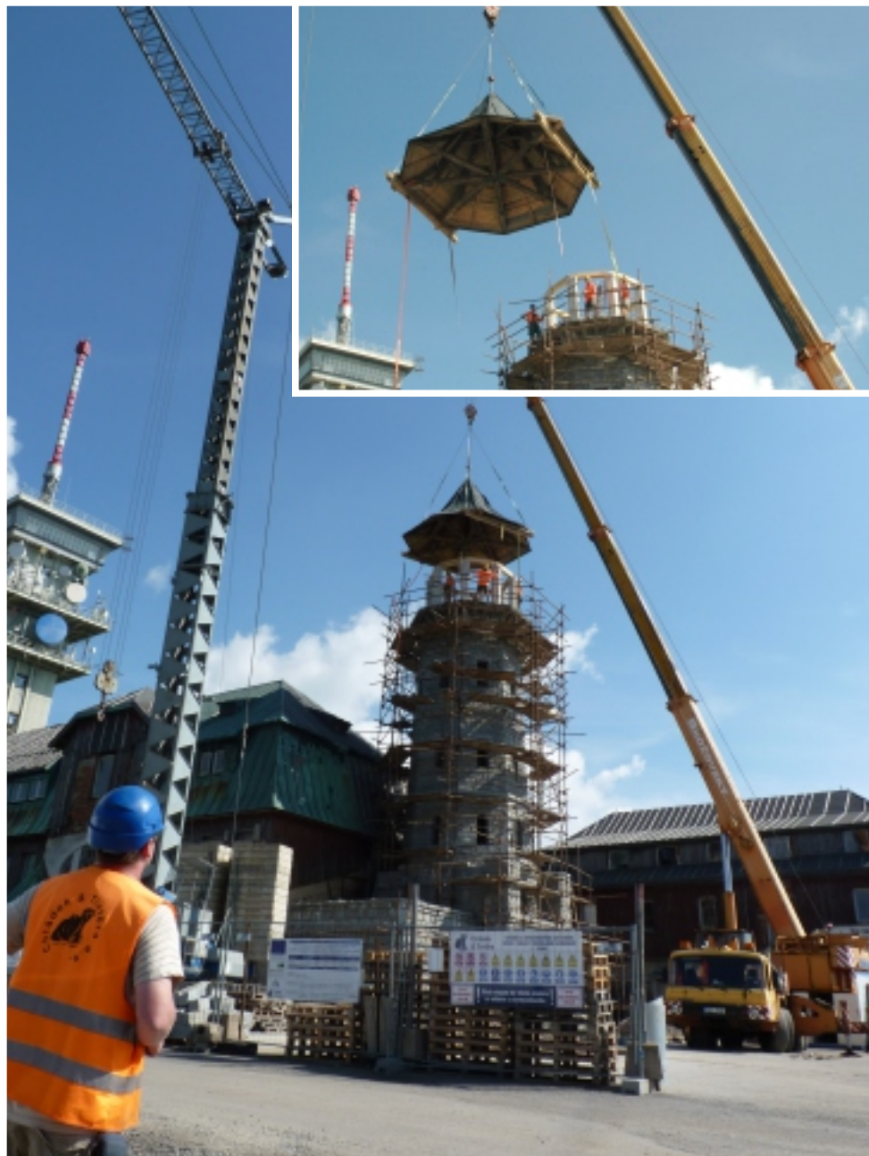
Původní střecha rozhledny bezpro- středně před osazením 26.7.2013
