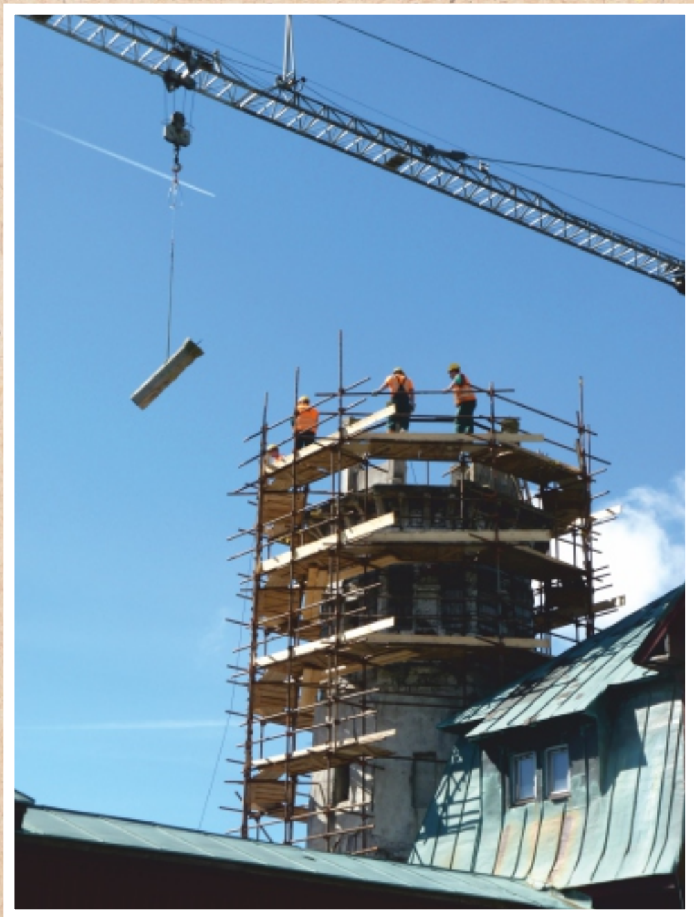
Snesení jednoho z osmi kamenných sloupků ochozu rozhledny 1.8.2012
