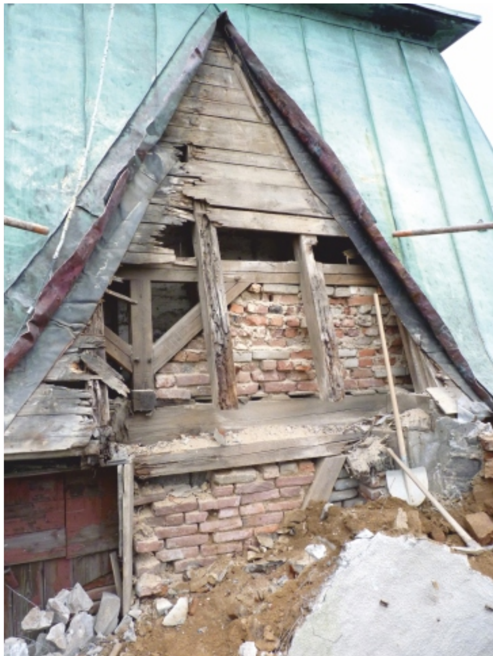
Destrukce hrázděného zdiva hotelu přiléhajícího k rozhledně – celkový pohled 16.8.2012
