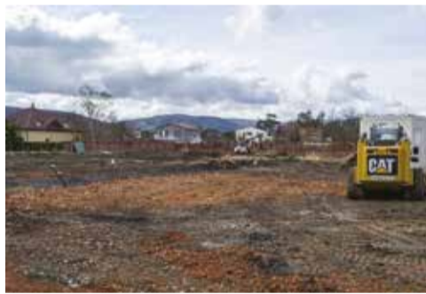
Výstavba komplexu začala úpravou zemní pláně.
