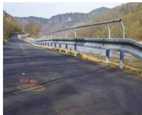
ROZŠÍŘENÍ. Komunikace se dočkala potřebného rozšíření na 3,25 metru a výhyben.
